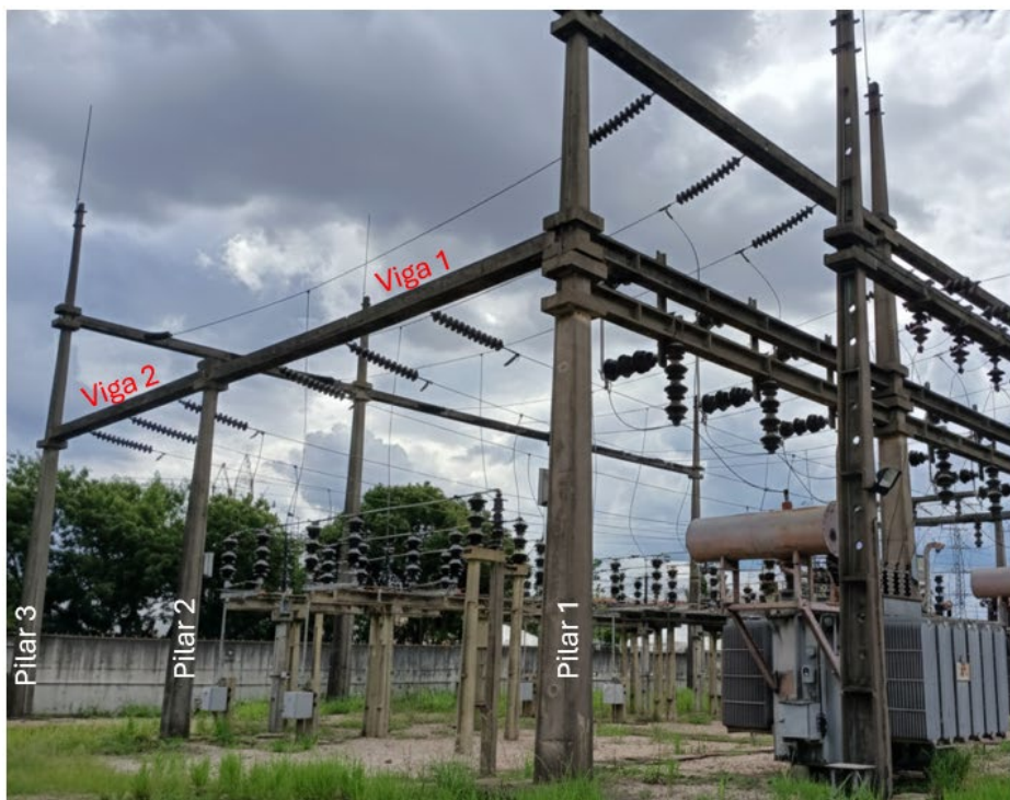
Fotos 1 e 2 – Conjunto com Três Pilares e Duas vigas – 88KV e Pilar 34KV para recuperação, respectivamente.
