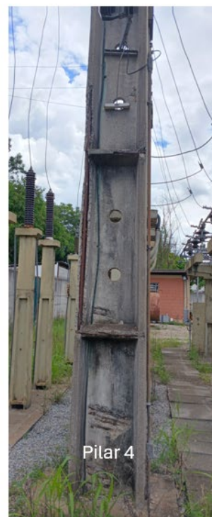
Fotos 1 e 2 – Conjunto com Três Pilares e Duas vigas – 88KV e Pilar 34KV para recuperação, respectivamente.
