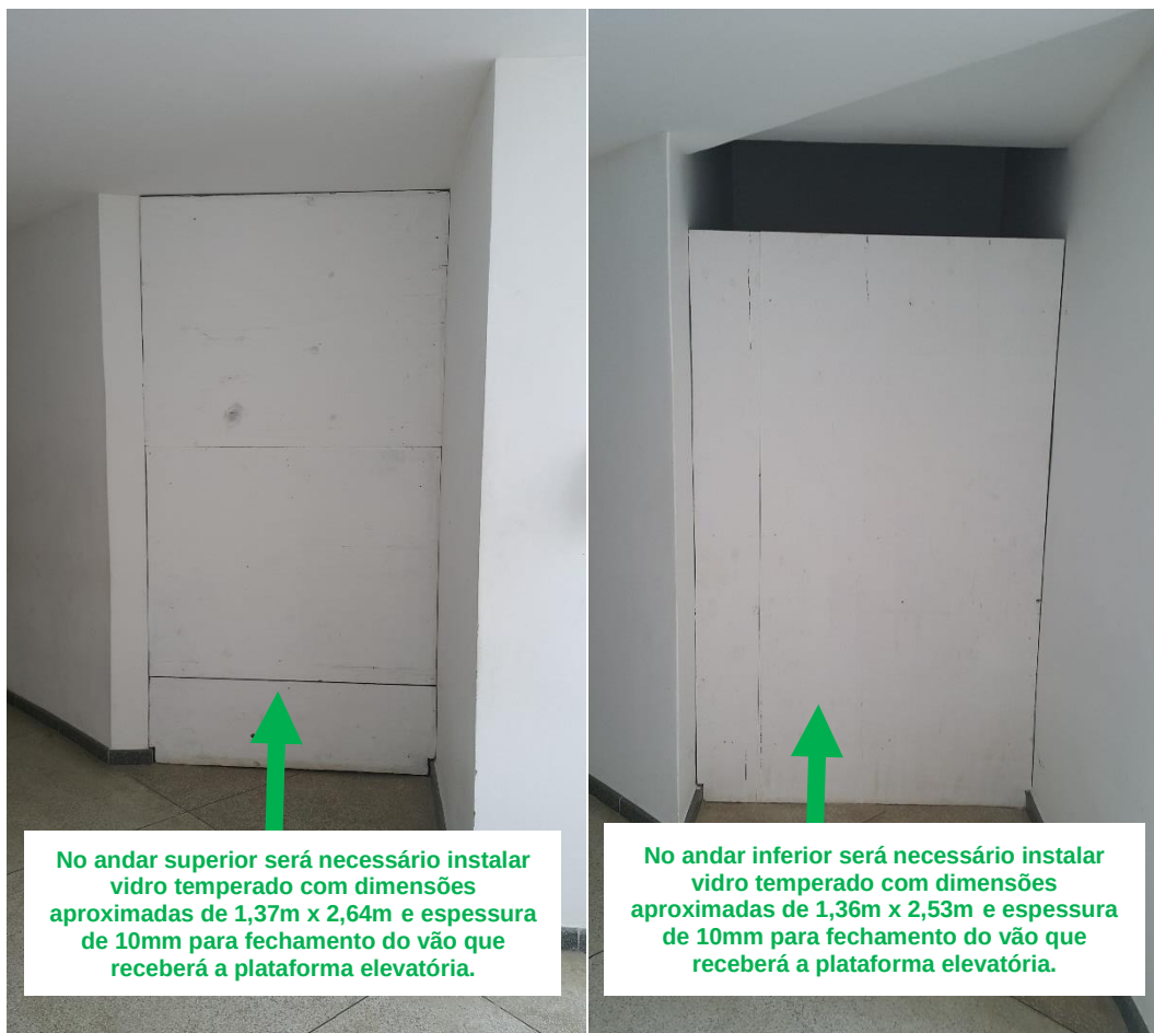
Foto 04 – Locais para instalação de vidro para fechamento
