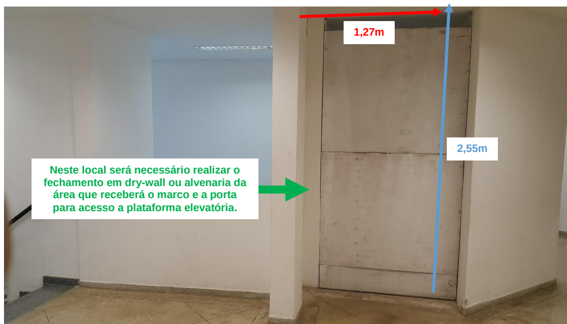
Foto 05 - Local para instalação (andar superior)
