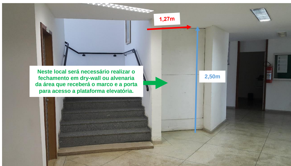
Foto 06 - Local para instalação (andar inferior)
