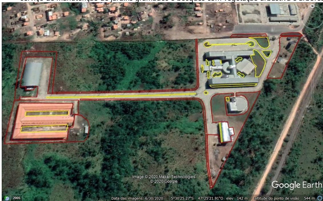
Imagem 12. Vista geral do Campus Imperatriz- unidade Bom Jesus , com delimitação das áreas para serviço de manutenção de jardins gramados e bosques com vegetação arbustiva e arbórea.
