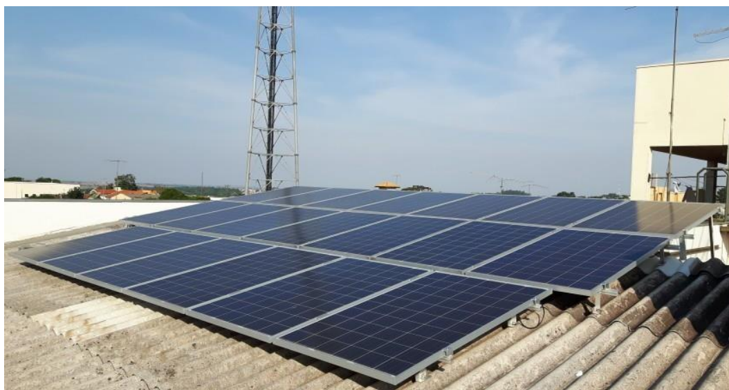
Figura 6 - Suporte para fixação dos módulos
