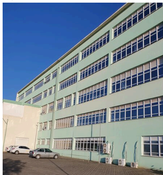
Figura: Detalhes das esquadrias basculantes da edificação predial correspondente ao Bloco B de 5 pavimentos
