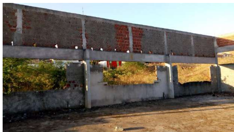
Fotografia n.º 25 – elevação interna Noroeste Laboratórios.
