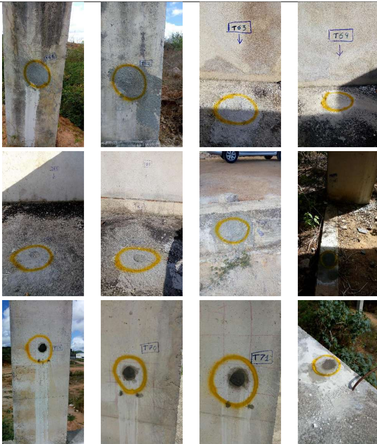
Fotografias n.º 532 a 543 – extração de testemunhos no Ginásio (T61, T62), Auditório (T63 a T65), Biblioteca (T67) e Bloco Pedagógico (T68 a T62).
