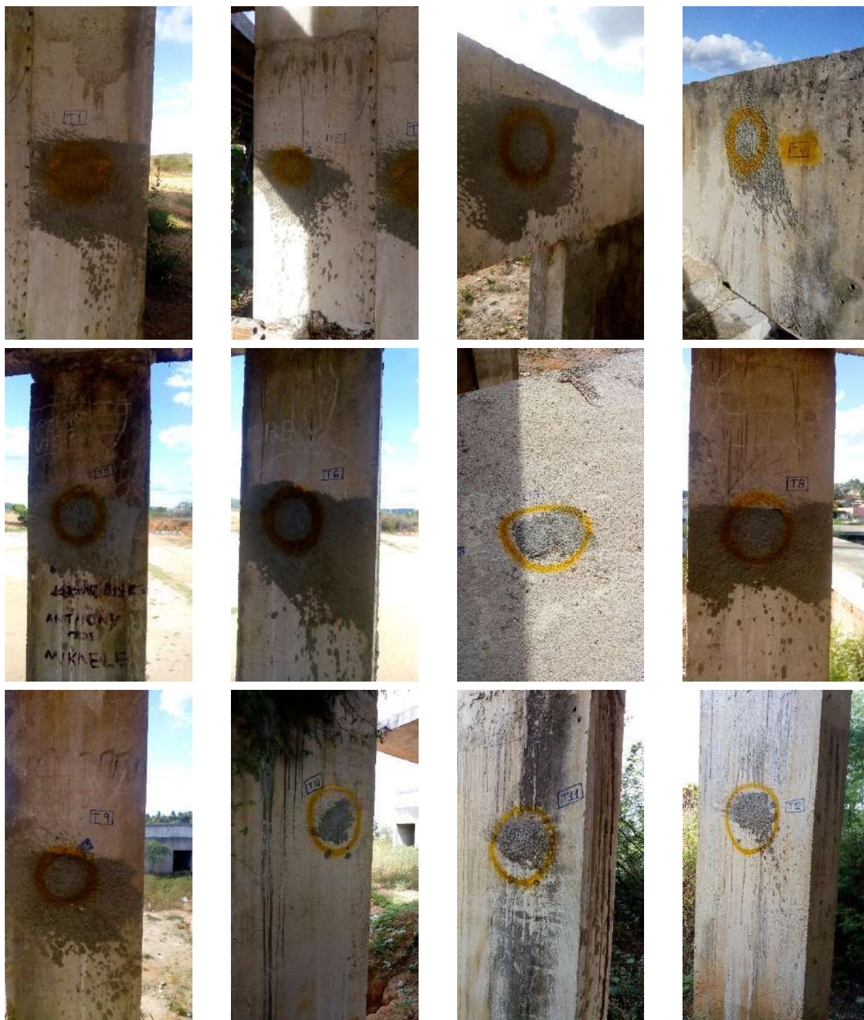
Fotografias n.º 472 a 483 – extração de testemunhos no Bloco Pedagógico (T1, T10, T11 e T12) e Biblioteca (T2 a T9).
