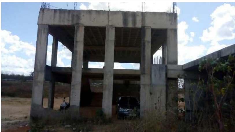
Fotografia n.º 04 – estrutura da Biblioteca, elevação Nordeste.
