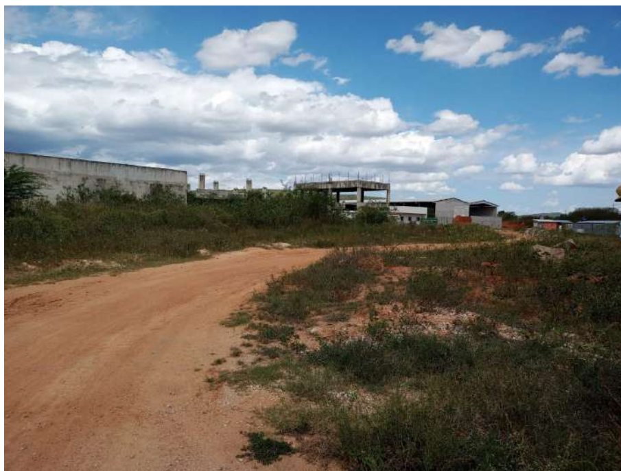
Figura 5 – Vista frontal da obra.
