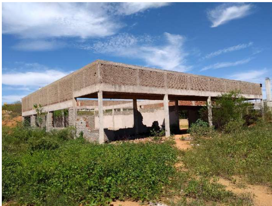
Figura 19 – Bloco de Laboratórios Especiais.
