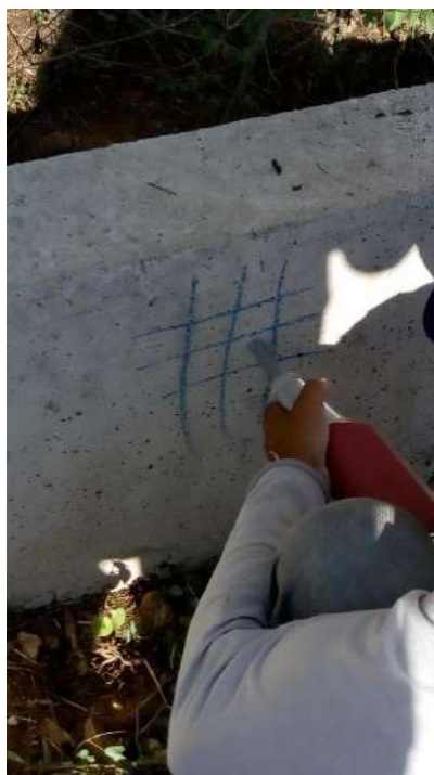
Fotografias n.º 136, 137, 138 e 139 – ensaio de esclerometria da Ginásio S5, V4, V5 e V12 (pavimento fundação) respectivamente.
