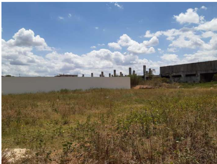
Figura 9 – Vista posterior do muro de contorno da obra do Mercado Público Municipal, nos limites do terreno do Ifal.
