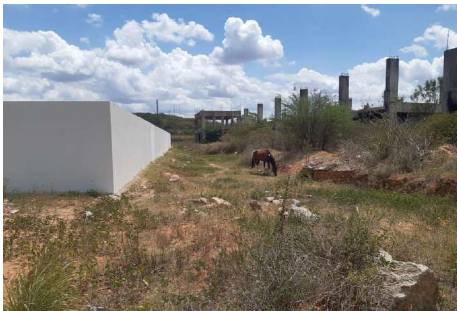
Figura 7 – Vista lateral esquerda da obra do Ifal, com muro de contorno da obra do Mercado Público Municipal.
