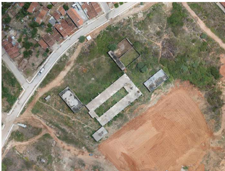
Figura 1 – Visão geral da obra registrada durante levantamento topográfico realizado em 2022.
