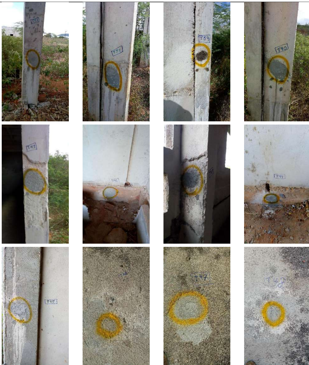
Fotografias n.º 508 a 519- extração de testemunhos no Laboratório (T37), Vivencia (T38, T40 a T48) e Passarela (T39).
