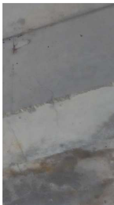
Fotografias n.º 749 e 750 – fissuras a flexão.
