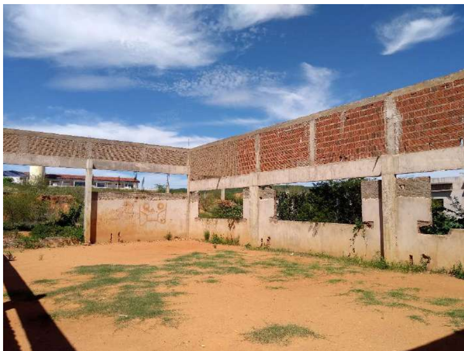
Figura 20 – Bloco de Laboratórios Especiais.
