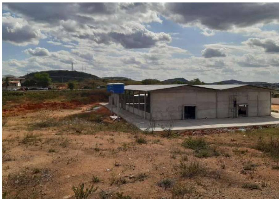
Figura 12 – Edificações do Mercado Público Municipal executadas no local do antigo barracão da obra de construção do Campus Santana do Ipanema.
