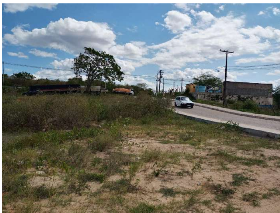
Figura 4 – Interligação da rua pavimentada na lateral direita da obra com a BR-316.
