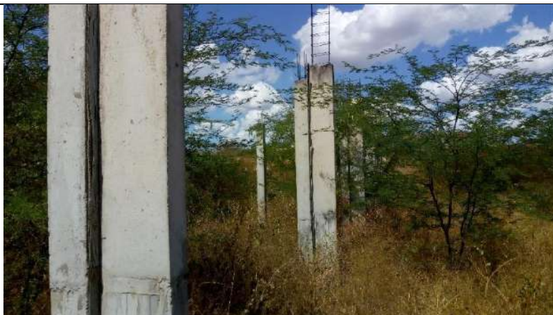
Fotografia n.º 44 – visão geral por outro ângulo da estrutura da Passarela.
