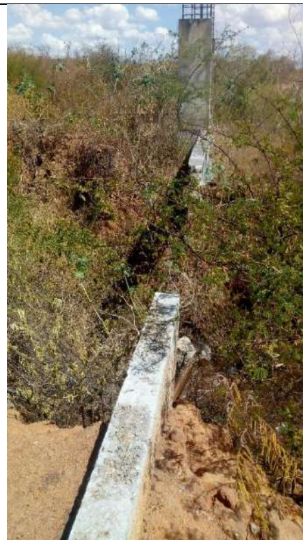
Fotografias n.º 754 e 755 – viga baldrame colapsada.
