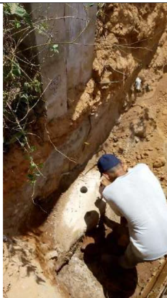
Fotografia n.º 205 – ensaio de esclerometria da Passarela S25 (pavimento fundação).
