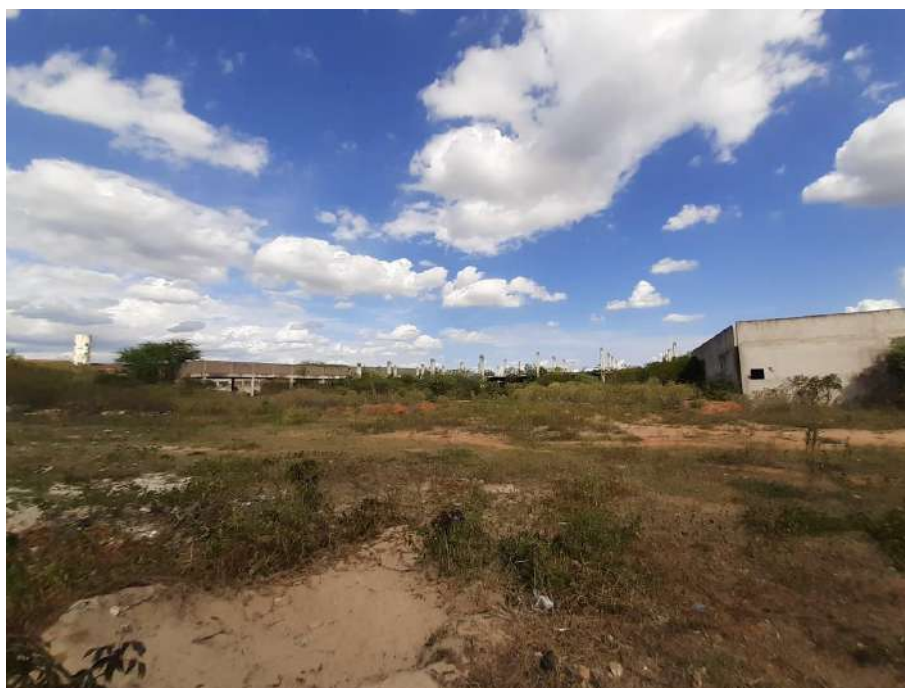
Figura 2 – Vista lateral direita da obra.
