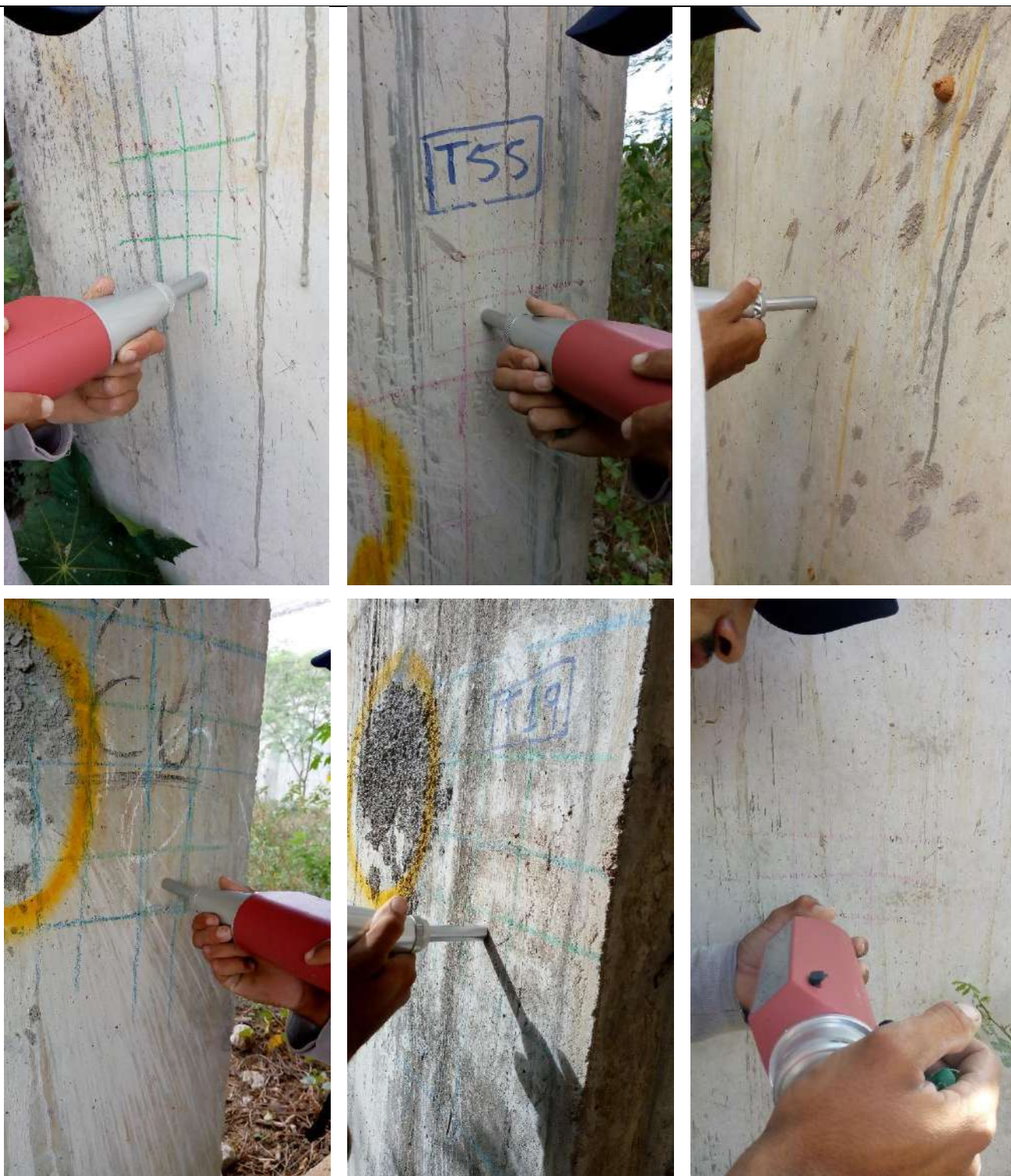
Fotografias n.º 227, 228, 229, 230 231 e 232 – ensaio de esclerometria do Bloco Pedagógico P5, P6, P7, P8, P9 e P10 (pavimento térreo) respectivamente.
