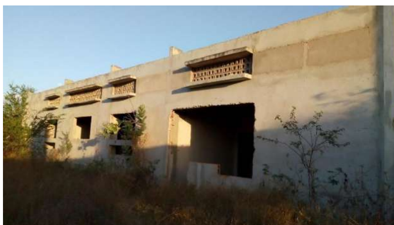
Fotografia n.º 29 – elevação Noroeste Vivência.
