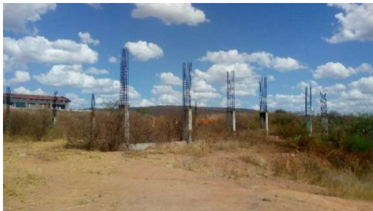
Fotografia n.º 40 – elevação Noroeste da estrutura da quadra poliesportiva.
