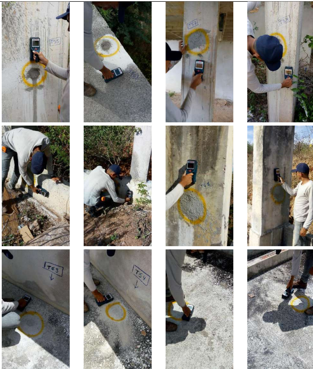
Fotografias n.º 415 a 426 – ensaio de Pacometria, Pilar P6, Viga V15, Pilar P13, Pilara P23 (Bloco Pedagógico – térreo); Viga Baldrame V5 (Ginásio – fundação); Pilar P5, P6, P12 (Ginásio – térreo); Lajes L1, L2, Viga V5, Laje L4 (Auditório – térreo);
