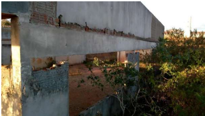
Fotografia n.º 26 – elevação interna Sudeste Laboratórios.
