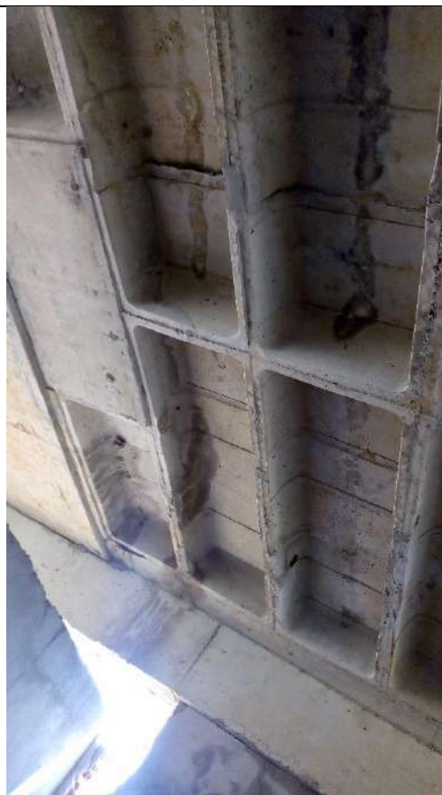
Fotografias n.º 715 e 716 – indicando a posição das fissuras em relação a viga V6
