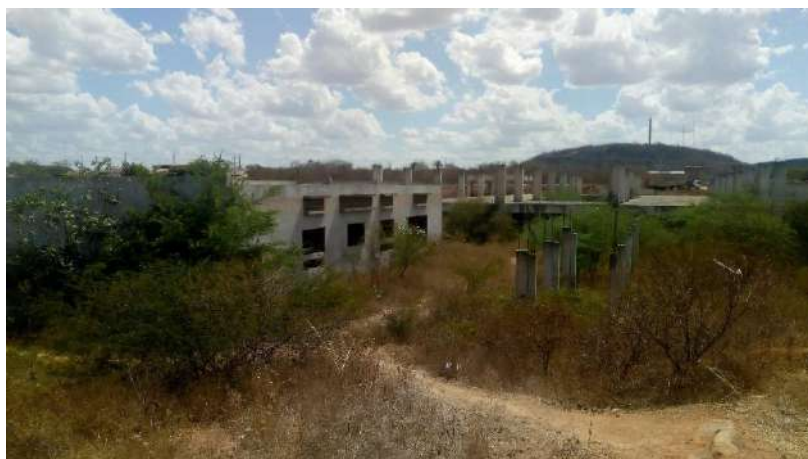
Fotografia n.º 28 – elevação Nordeste Vivência.
