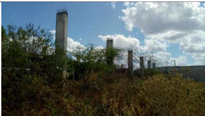
Fotografia n.º 18 – elevação Noroeste do Bloco Pedagógico.
