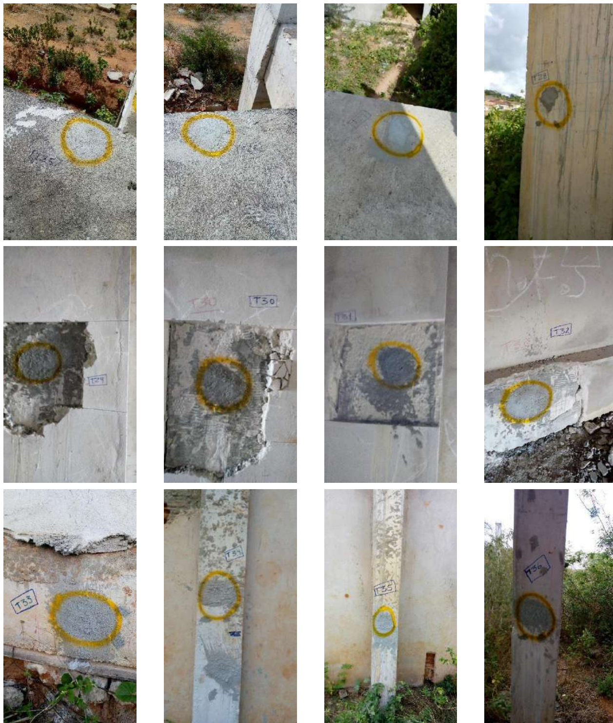
Fotografias n.º 496 a 507 – extração de testemunhos no Bloco Pedagógico (T25 a T28), Auditório (T29 a T33) e Laboratório (T34 a T36).
