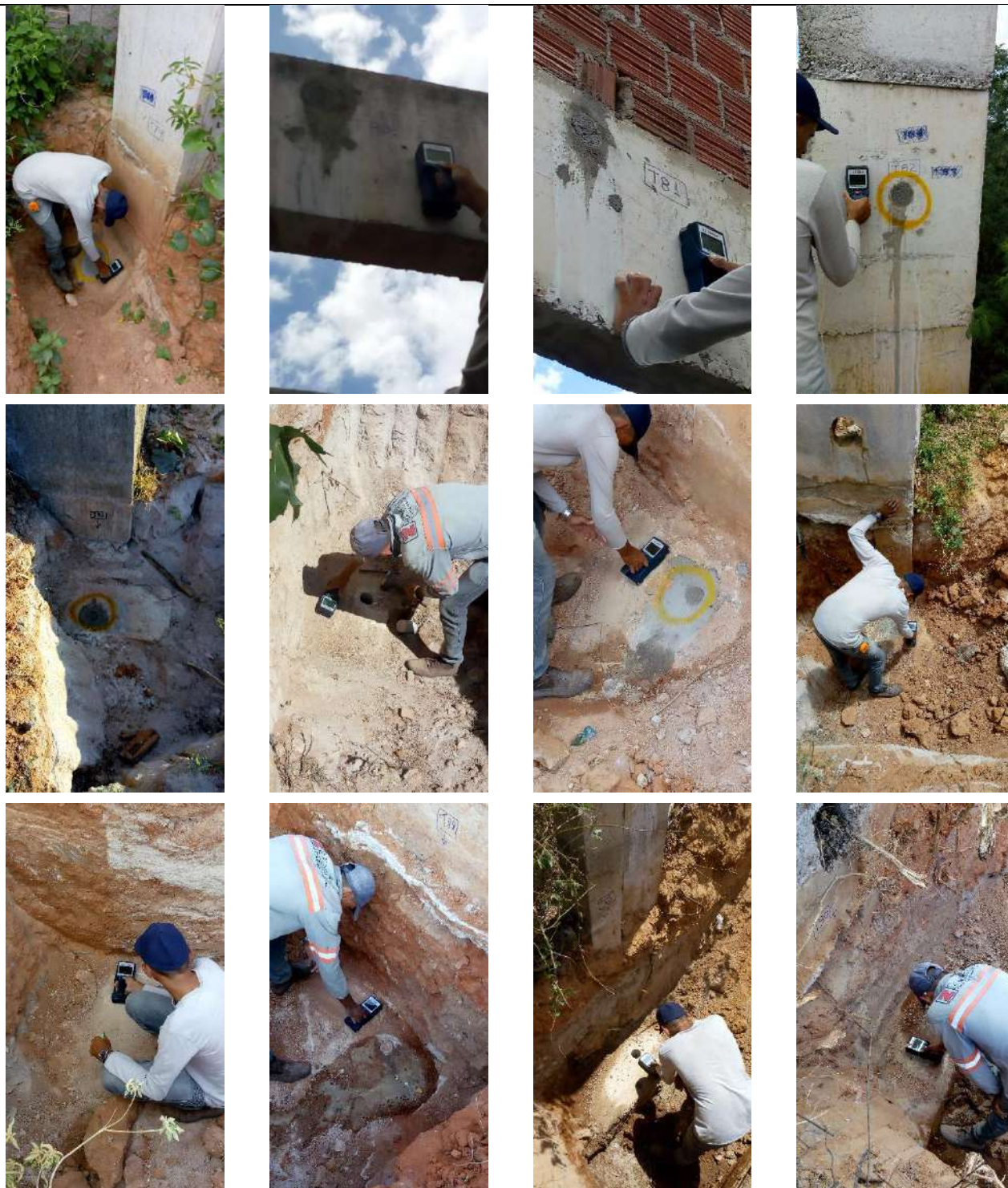
Fotografias n.º 440 451 – ensaio de Pacometria, Sapata S4 (Bloco Pedagógico – fundação); Vigas V2, V3 (Laboratório – térreo); Pilar P7 (Bloco Pedagógico – térreo); Sapatas S5, S1 (Biblioteca – fundação); Sapata S19 (Bloco Pedagógico – fundação); Sapata S12 (Auditório – fundação); Sapata S1 (Guarita – fundação); Sapata S3 (Auditório – fundação); Sapata S5 (Passarela – fundação); Sapata S32 (Vivencia – fundação).
