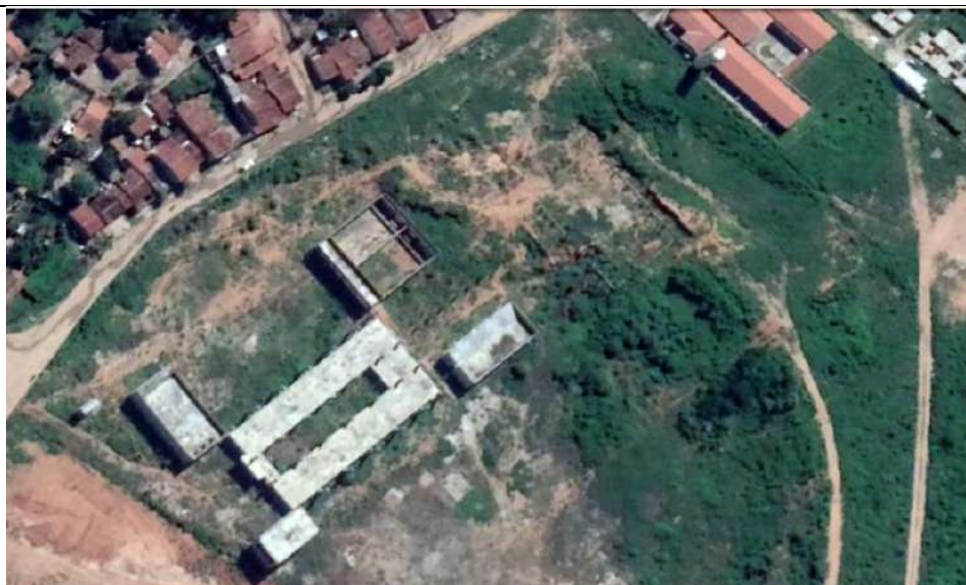
Imagem n.º 03 – visão geral das principais edificações iniciadas e paralisadas fonte Google Earth (2016).
