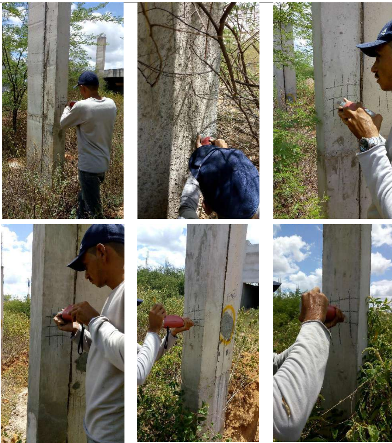
Fotografias n.º 199, 200, 201, 202, 203 e 204 – ensaio de esclerometria da Passarela P21, P22, P23, P24, P25 e P26 (pavimento térreo) respectivamente.
