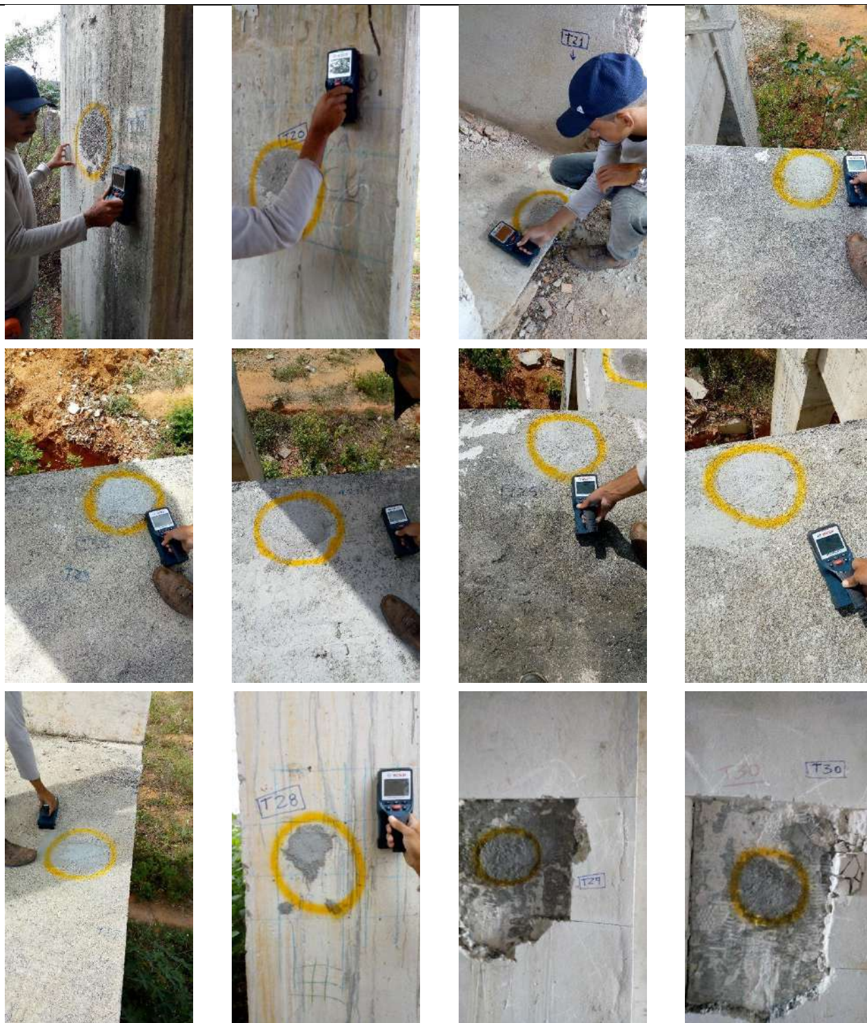
Fotografias n.º 379 a 390 – ensaio de Pacometria, Pilar P9, Pilar P8 (Bloco Pedagógico – térreo); Viga Baldrame V2 (Bloco Pedagógico – fundação); Lajes L15, L12, L14, L6, L7A, Pilar P1, (Bloco Pedagógico – térreo); Pilares P8 e P9 (Auditório – térreo) respectivamente.
