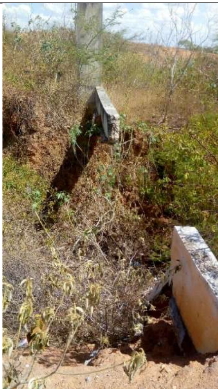
Fotografias n.º 754 e 755 – viga baldrame colapsada.
