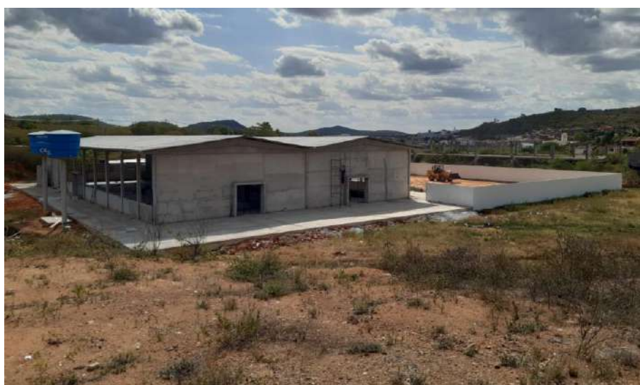
Figura 8 – Vista posterior da obra do Mercado Público Municipal, vizinho à obra de construção do Campus Santana do Ipanema.
