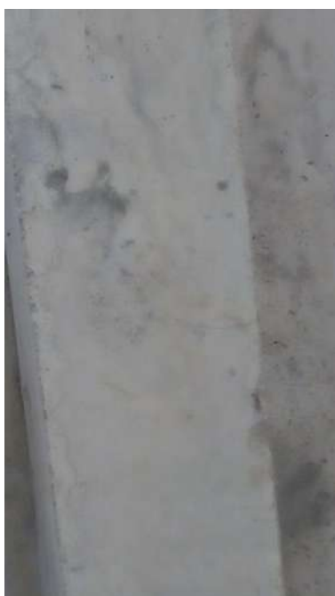
Fotografias n.º 749 e 750 – fissuras a flexão.
