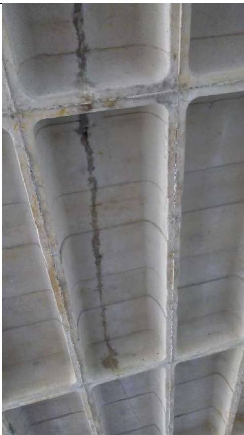
Fotografias n.º 715 e 716 – indicando a posição das fissuras em relação a viga V6
