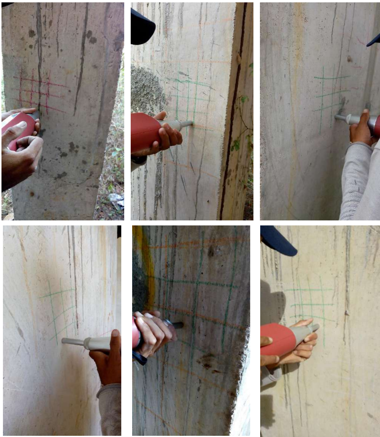
Fotografias n.º 239, 240, 241, 242, 243 e 244 – ensaio de esclerometria do Bloco Pedagógico P21, P22, P23, P24, P25 e P26 (pavimento térreo) respectivamente.
