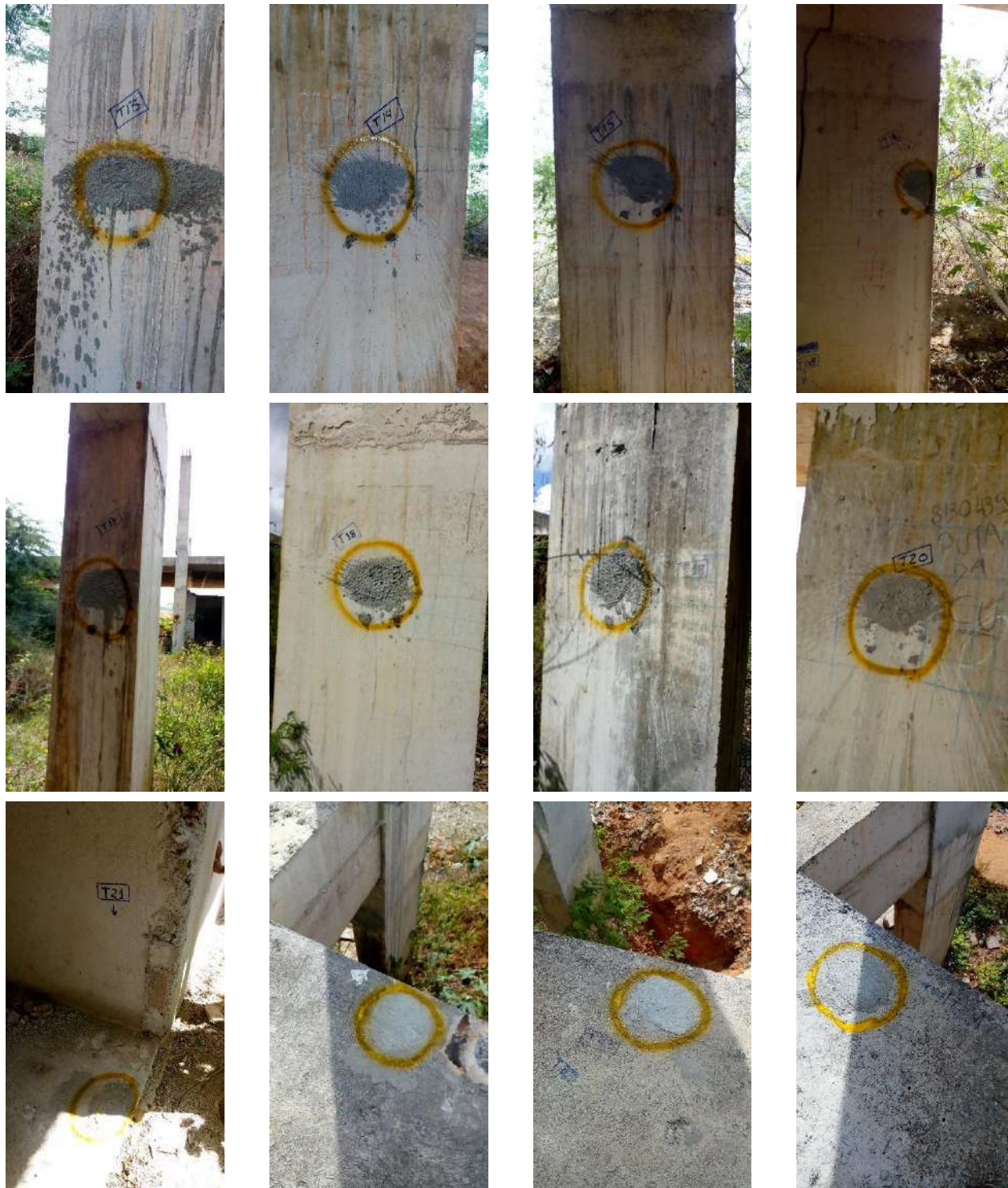
Fotografias n.º 484 a 495 – extração de testemunhos no Bloco Pedagógico (T13 a T24).
