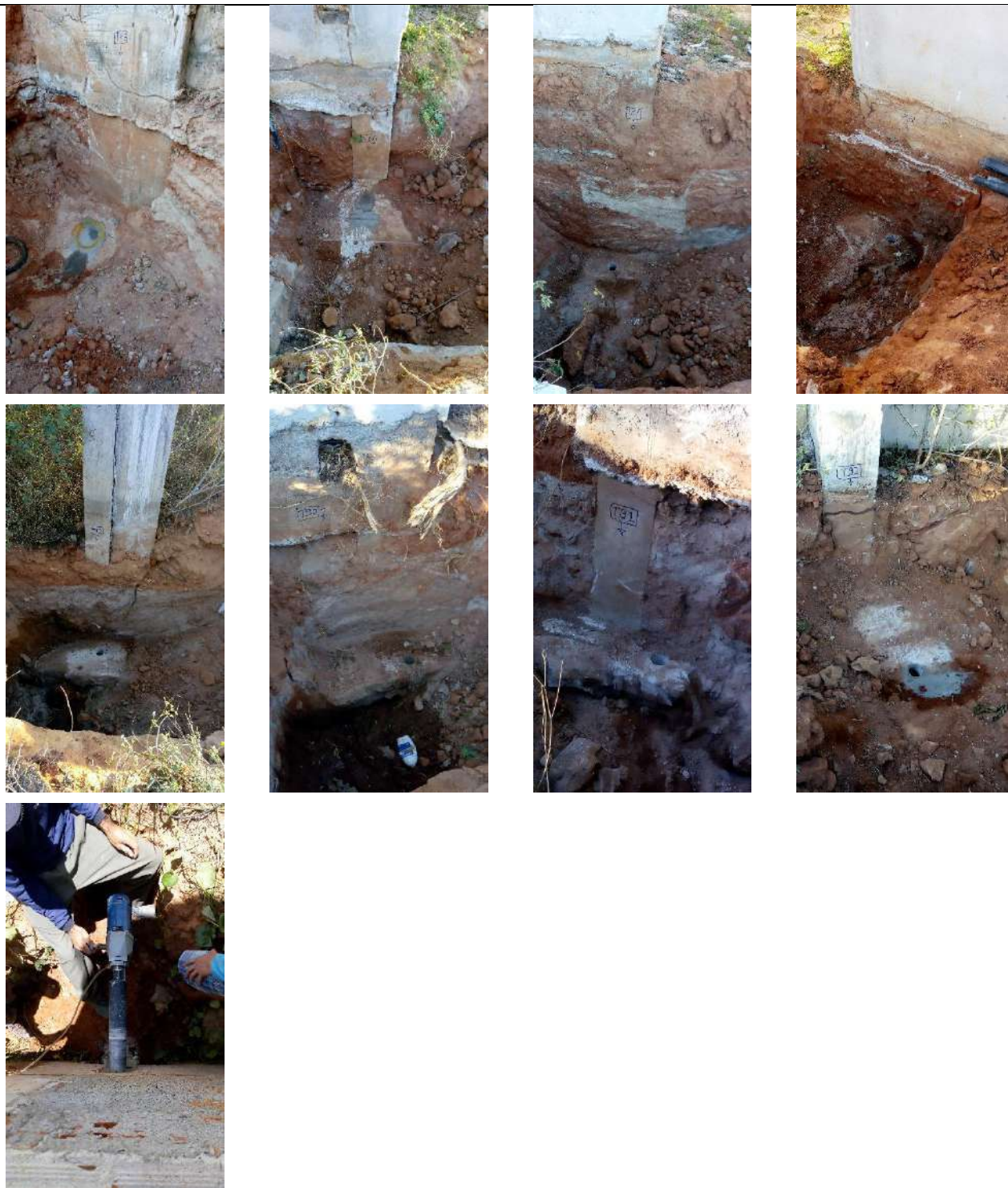
Fotografias n.º 556 a 604 – extração de testemunhos no Bloco Pedagógico (T85), Auditório (T86, T88), Guarita (T87), Passarela (T89), Vivencia (T90, T91), Ginásio(T92) e Laboratório (T93).
