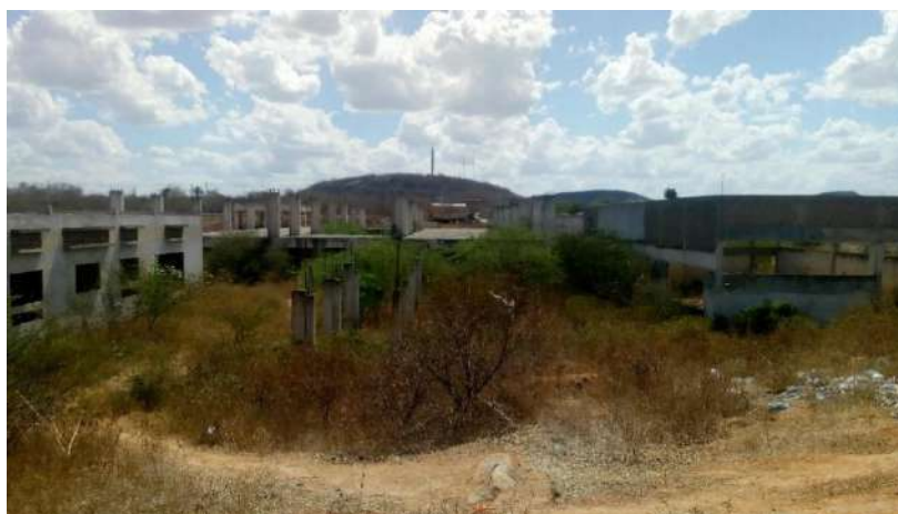
Fotografia n.º 42 – visão geral da estrutura da Passarela.
