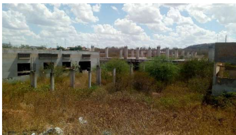
Fotografia n.º 43 – visão geral da estrutura da Passarela.
