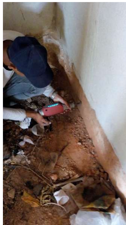
Fotografias n.º 311, 312, 313, 314, 315 e 316 – ensaio de esclerometria da Vivência S14, S32, V1, V2, V3 e V4 (pavimento fundação) respectivamente.
