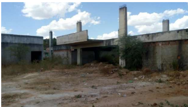
Fotografia n.º 16 – elevação Sudoeste do Bloco Pedagógico.
