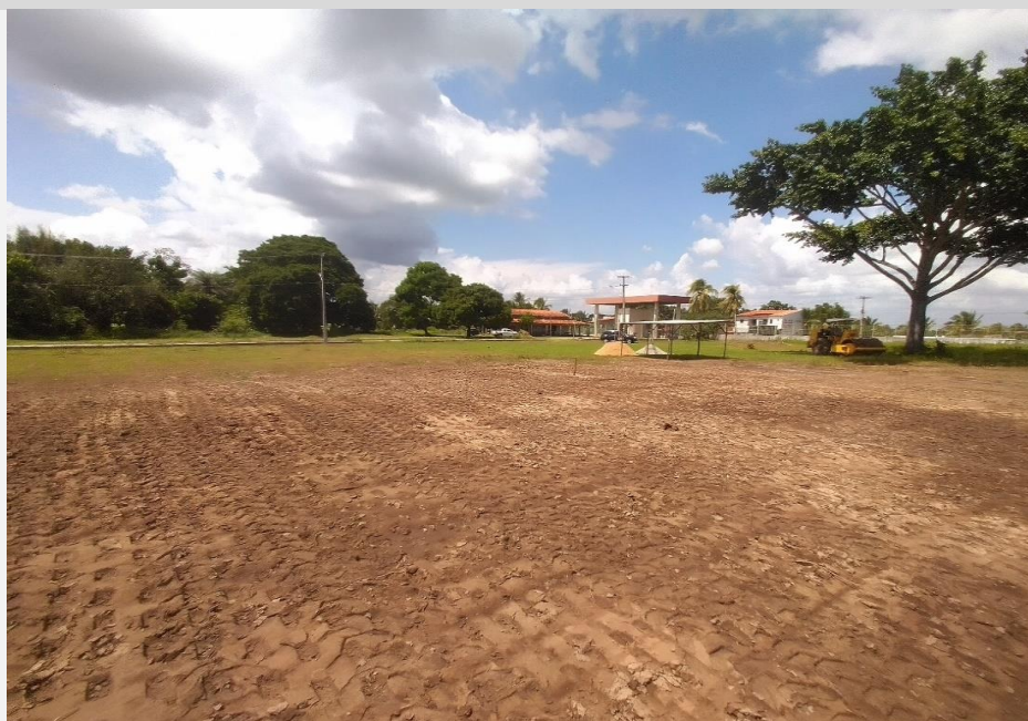
Movimento de terra e formação do Platô inclusive compactação (12-01-2023)
