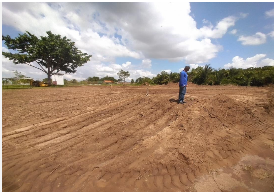
Movimento de terra(material local) e formação do Platô (12-01-2023)
