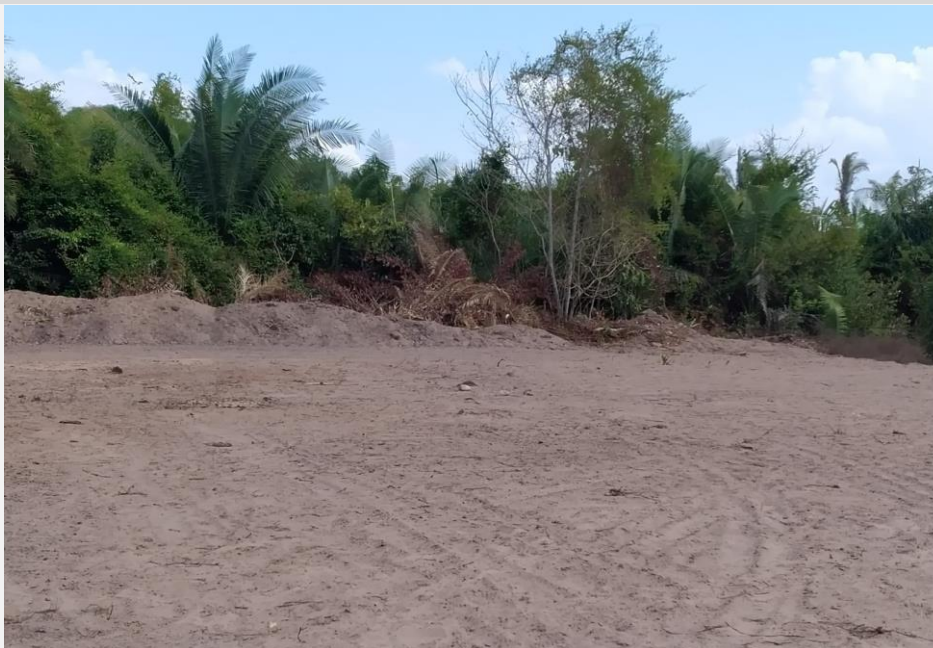
Limpeza da área e início do movimento do solo (20-10-2022)
