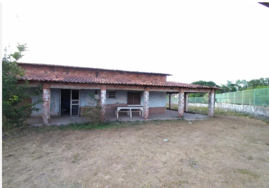
Local cedido para instalações de barracão antes de intervenções para uso (20-10-2022)
