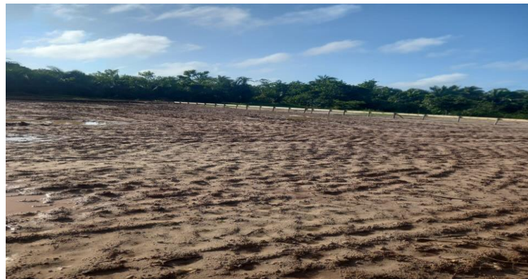
Terraplanagem, Nivelamento com Importação de Material e Compactação da Área
