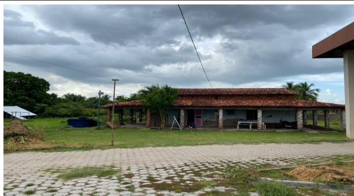
Casa existente que servirá de apoio para o canteiro de obra
