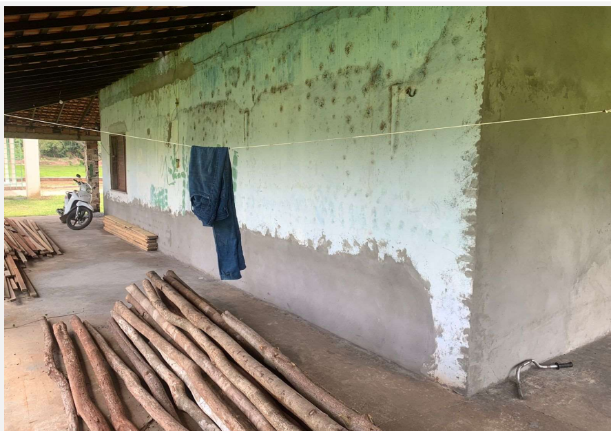
Recuperação de reboco em construção para utilização como barracão da obra
