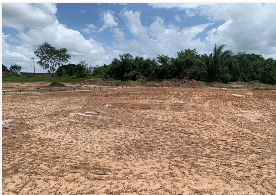
Camada laterítica espalhada sem finalização de compactação
