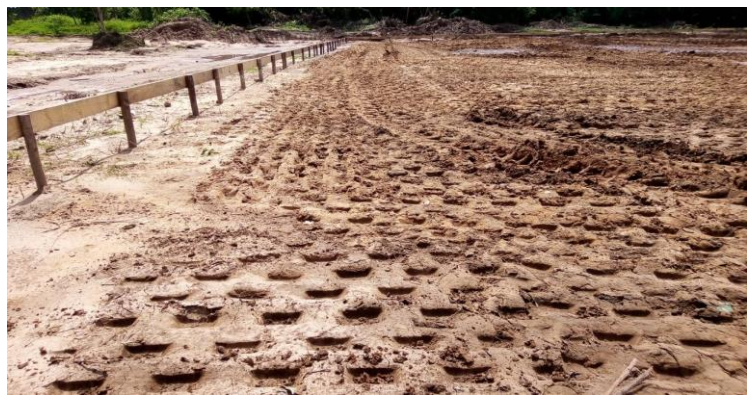
Terraplanagem, Nivelamento com Importação de Material e Compactação da Área
