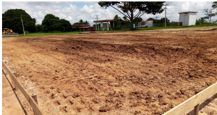
Terraplanagem, Nivelamento com Importação de Material e Compactação da Área
