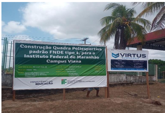
Placas de Identificação de obra
