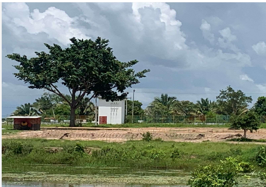
Área da implantação com abrigo de betoneira, gabarito e camada laterítica
