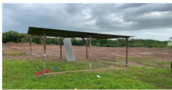
Abrigo para a Betoneira
