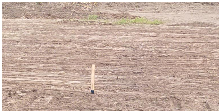
Limpeza, Aterro e Terraplanagem da área
