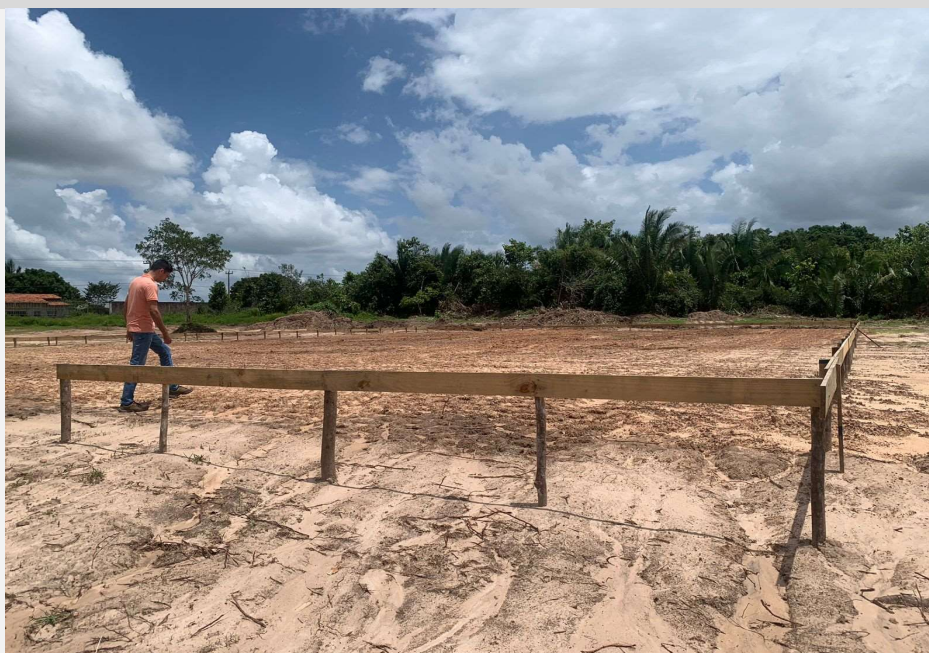
Gabarito em madeira para locação
