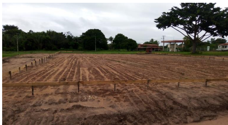
Terraplanagem, Nivelamento com Importação de Material e Compactação da Área
