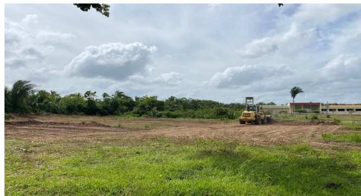
Limpeza, Aterro e Terraplanagem da área
