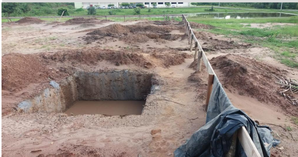
Área da implantação com abrigo de betoneira, gabarito e camada laterítica
