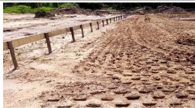
Gabarito de Obra
