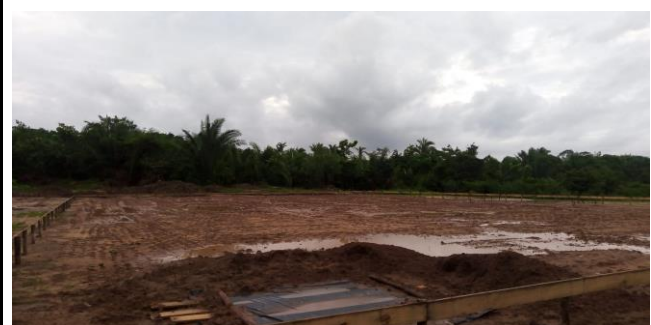
Marcação e Escavação de Sapatas
