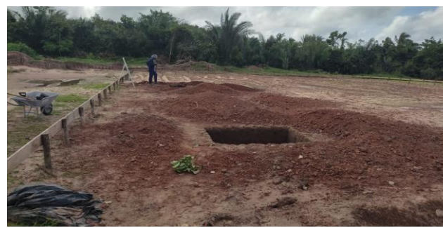
Marcação e Escavação de Sapatas
