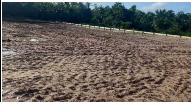
Terraplanagem, Aterro e Compactação de Área
