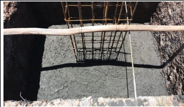
Armação de Ferragens para Sapatas e Arranque de Pilares
