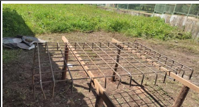
Armação de Ferragens para Sapatas e Arranque de Pilares
