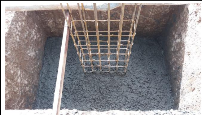
Armação de Ferragens para Sapatas e Arranque de Pilares
