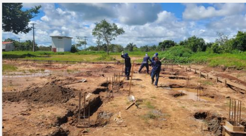
Escavação para vigas baldrames
