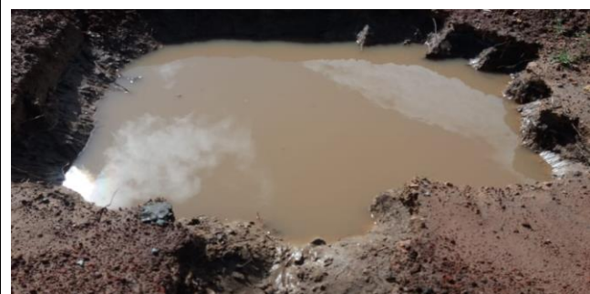
Escavação de Solo para execução de Sapatas e Arranque de Pilares - Chuvas Intensas
