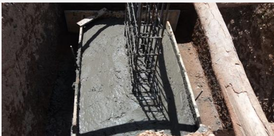
Concretagem de sapata
