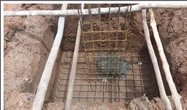
Armação de Ferragens para Sapatas e Arranque de Pilares
