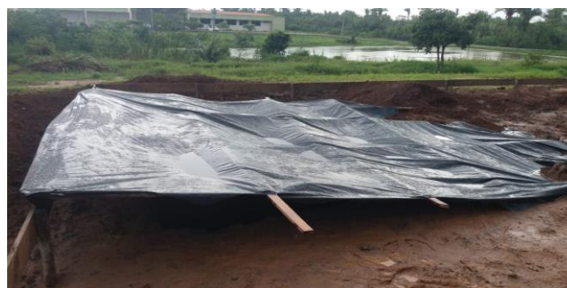
Escavação de Solo para execução de Sapatas e Arranque de Pilares - Chuvas Intensas
