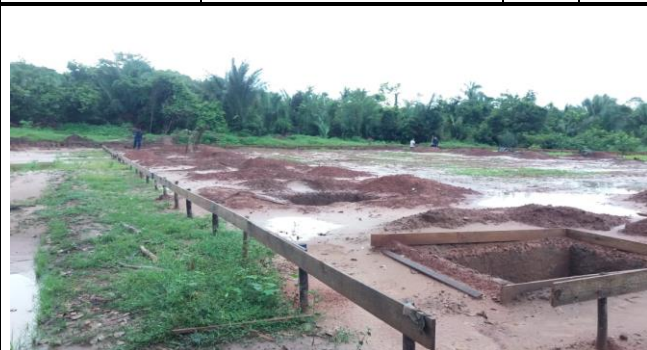
Escavação de Solo para execução de Sapatas e Arranque de Pilares - Chuvas Intensas
