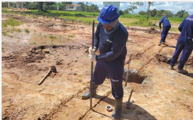
Escavação para viga baldrame
