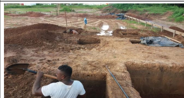
Escavação de Solo para execução de Sapatas e Arranque de Pilares - Preparação de Buracos com Lançamento de Chapisco e Concreto Magro
