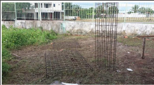
Armação de Ferragens para Sapatas e Arranque de Pilares
