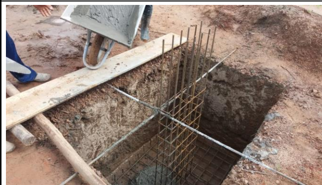
Armação de Ferragens para Sapatas e Arranque de Pilares
