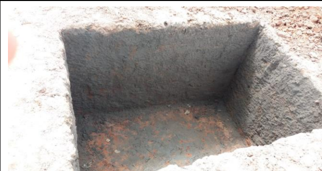
Escavação de Solo para execução de Sapatas e Arranque de Pilares - Preparação de Buracos com Lançamento de Chapisco e Concreto Magro
