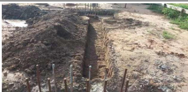
Arranque de Pilares e Escavação de valas para execução da Viga Baldrame
