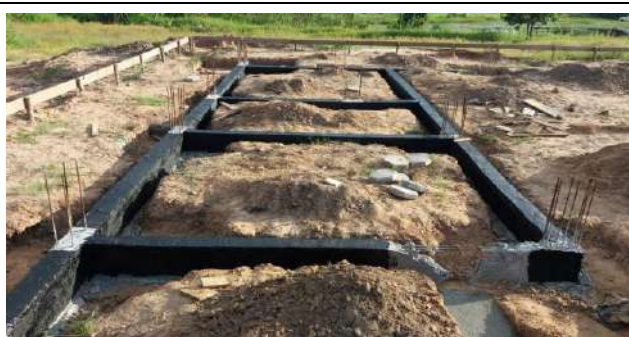
Pintura Impermeabilizante da Viga Baldrame e Enchimento e Reaterro de caixas para recebimento do piso
