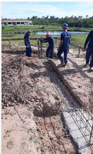
Execução de armadura para viga-baldrame.
