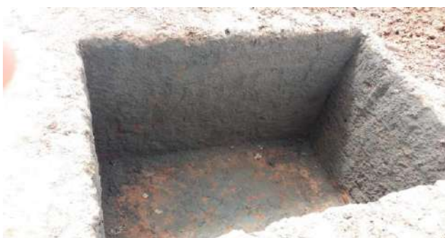
Escavação de Solo para execução de Sapatas e Arranque de Pilares - Preparação de Buracos com Lançamento de Chapisco e Concreto Magro
