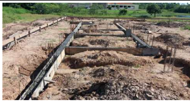
Armação de formas e ferragens e concretagem da Viga Baldrame
