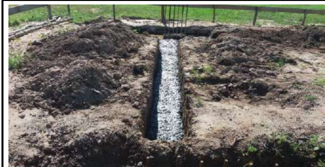
Lançamento de concreto magro na sub base da Viga baldrame
