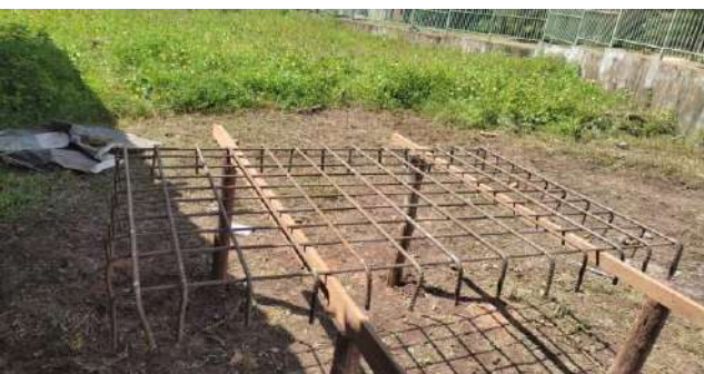
Armação de Ferragens para Sapatas e Arranque de Pilares
