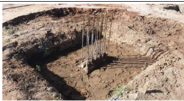
Concretagem das Sapatas e Arranque de Pilares
