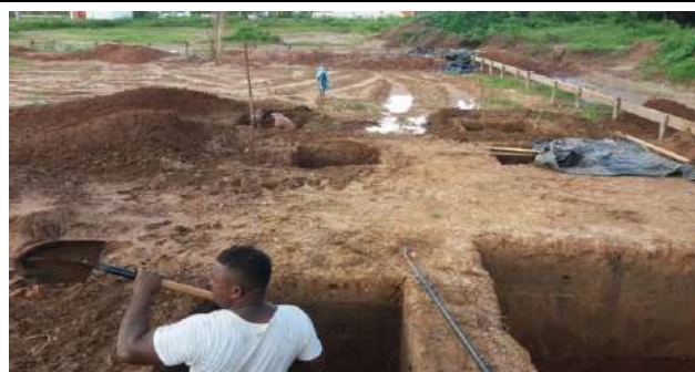
Escavação de Solo para execução de Sapatas e Arranque de Pilares - Preparação de Buracos com Lançamento de Chapisco e Concreto Magro
