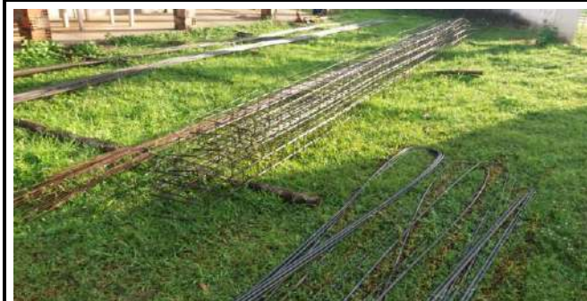
Armação de formas e ferragens e concretagem da Viga Baldrame
