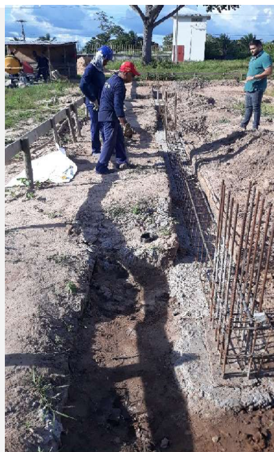
Execução de armadura para viga-baldrame.
