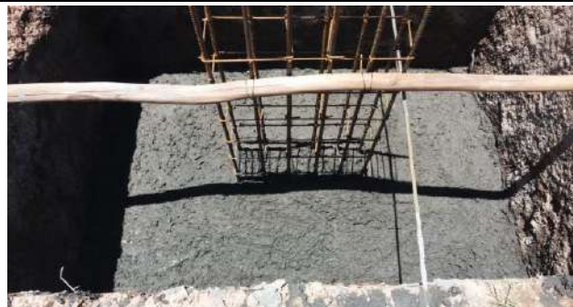
Concretagem das Sapatas e Arranque de Pilares
