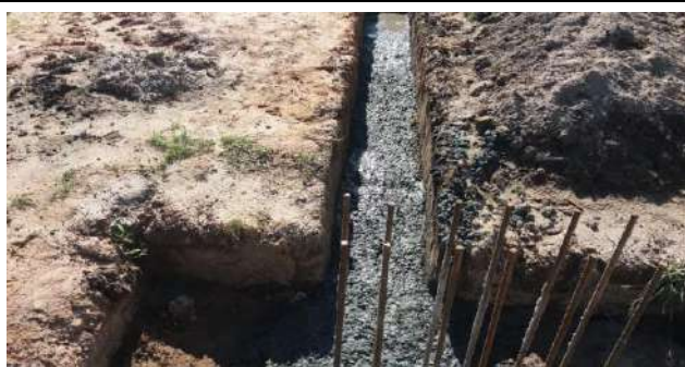
Lançamento de concreto magro na sub base da Viga baldrame
