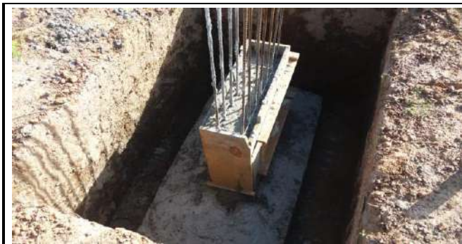
Concretagem das Sapatas e Arranque de Pilares
