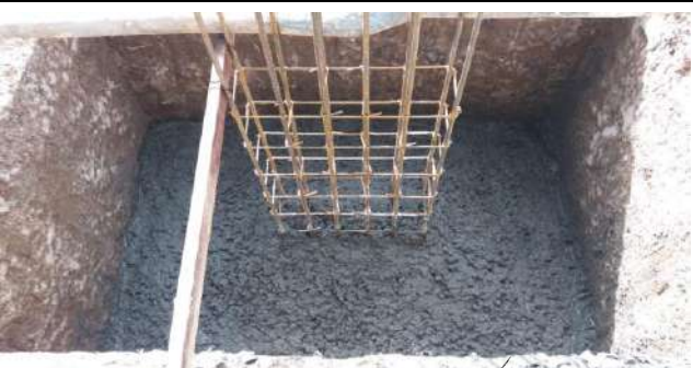
Concretagem das Sapatas e Arranque de Pilares
