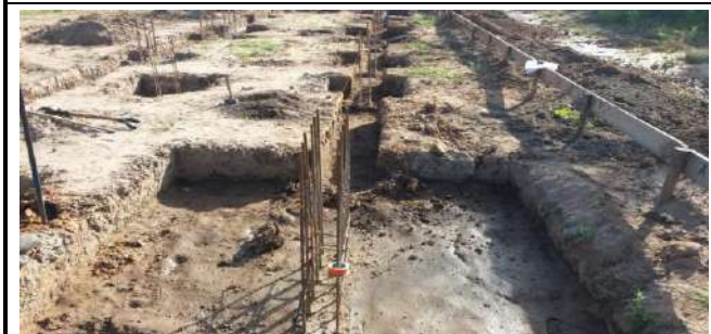
Arranque de Pilares e Escavação de valas para execução da Viga Baldrame
