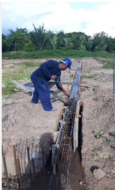
Concretagem de viga-baldrame.
