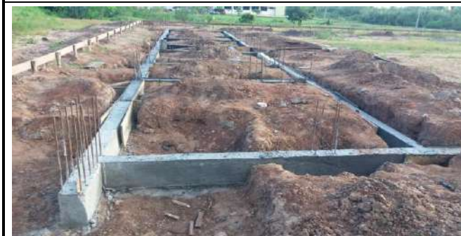
Pintura Impermeabilizante da Viga Baldrame e Enchimento e Reaterro de caixas para recebimento do piso
