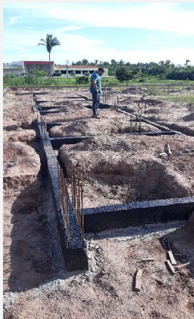
Impermeabilização de fundações/ vigas-baldrame.
