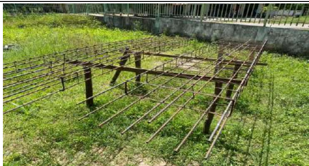
Armação de ferragens de Pilares de seção uniforme e variável
