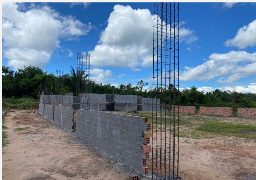
Execução de armaduras para pilares.
