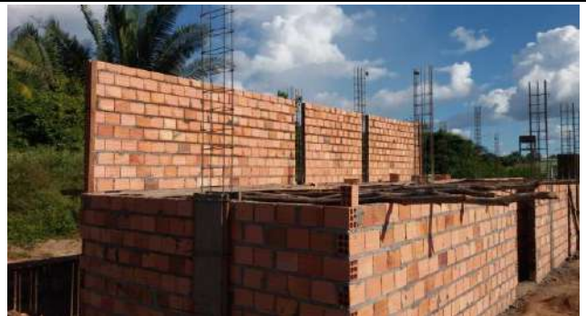
Execução de Alvenarias e Pilares de Seção Uniforme na ala do banheiros e vestiários
