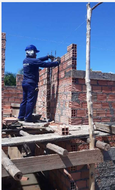
Execução de alvenaria.
