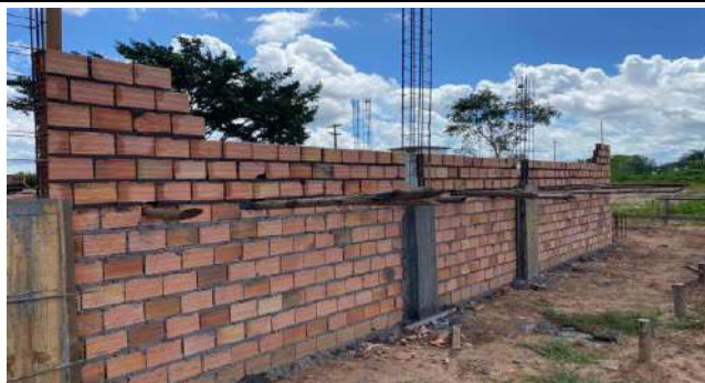
Execução de Alvenarias e Pilares de Seção Uniforme na ala do banheiros e vestiários
