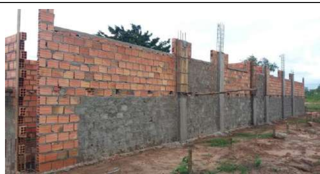
Armação de Formas e Ferragens dos Pilares de Seção Uniforme inseridos nas Alvenarias
