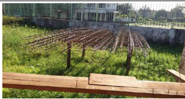
Armação de ferragens de Pilares de seção uniforme e variável
