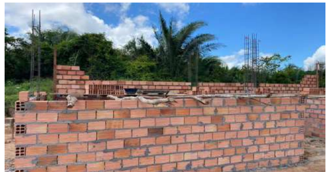
Execução de Alvenarias e Pilares de Seção Uniforme na ala do banheiros e vestiários
