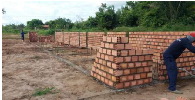
Execução de Alvenarias e Pilres de Seção uniforme na Ala de Banheiros
