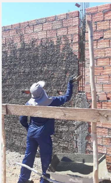
Execução de chapisco.
