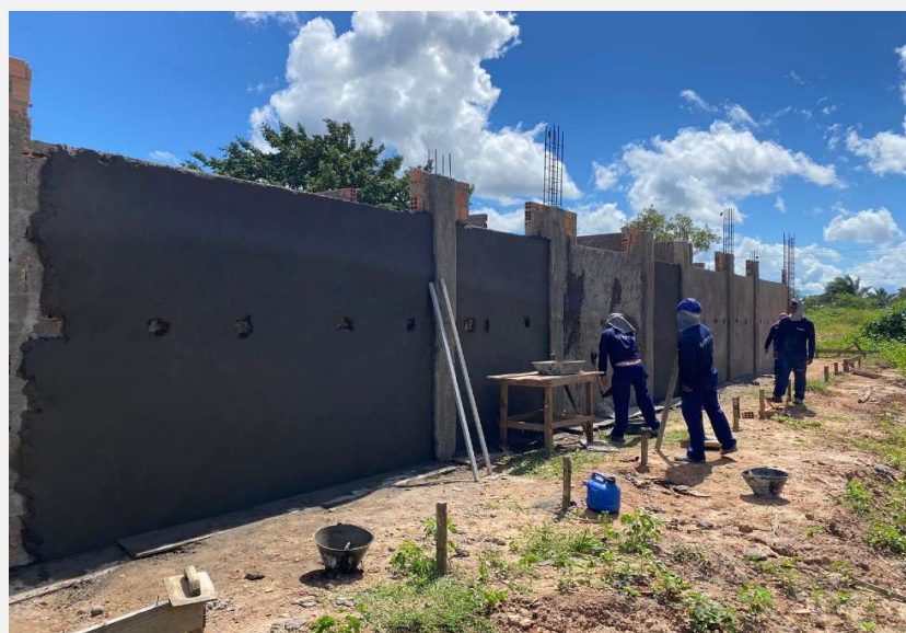
Execução de emboço.
