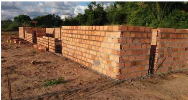
Execução de Alvenarias e Pilares de Seção Uniforme na ala do banheiros e vestiários
