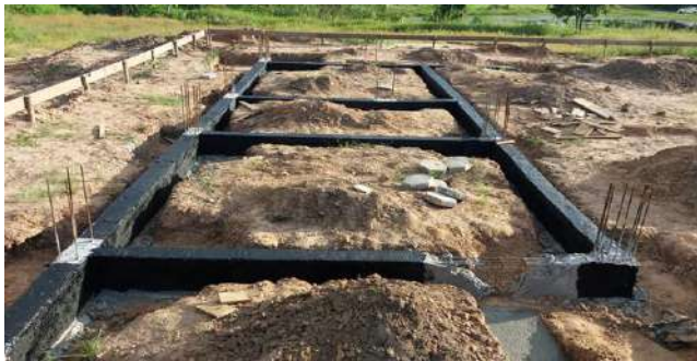
Viga Baldrame com Pintura Impermeabilizante e Enchimento de Caixas
