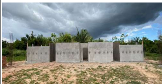
Chapisco e Rebouco nas Alvenarias Executadas de Alvenarias e Pilres de Seção Uniforme na Ala de Banheiros
