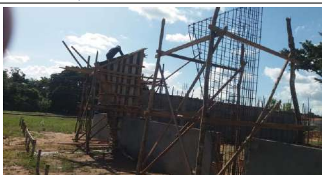
Armação de formas, Ferragens, Concretagem e Desforma dos Pilares de Seção Variável em Concreto Aparente
