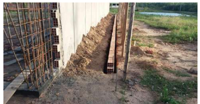
Execução da Calçada Externa e Pilares de Seção Variável
