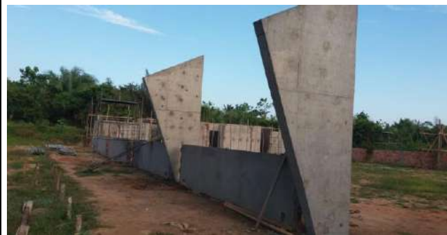
Armação de formas, Ferragens, Concretagem e Desforma dos Pilares de Seção Variável em Concreto Aparente
