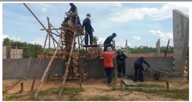
Armação de formas, Ferragens, Concretagem e Desforma dos Pilares de Seção Variável em Concreto Aparente
