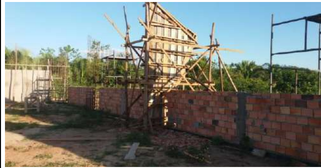
Armação de formas, Ferragens, Concretagem e Desforma dos Pilares de Seção Variável em Concreto Aparente
