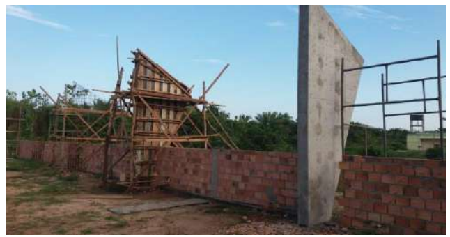
Armação de formas, Ferragens, Concretagem e Desforma dos Pilares de Seção Variável em Concreto Aparente
