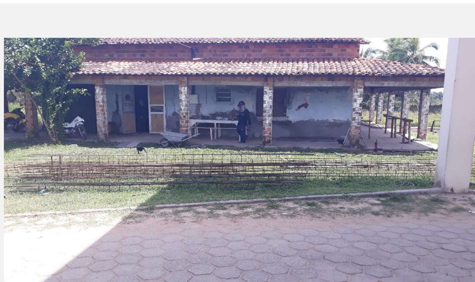
Execução de armaduras para vigas.
