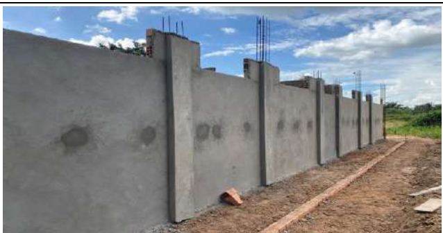
Chapisco e Rebouco nas Alvenarias Executadas de Alvenarias e Pilres de Seção Uniforme na Ala de Banheiros
