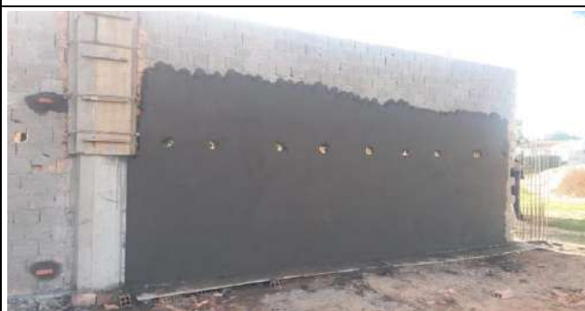
Chapisco e Rebouco nas Alvenarias Executadas de Alvenarias e Pilres de Seção Uniforme na Ala de Banheiros
