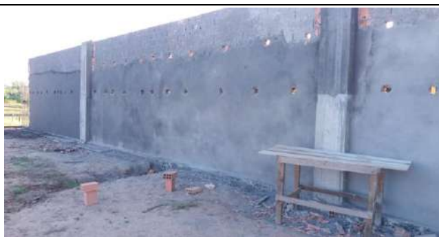
Chapisco e Rebouco nas Alvenarias Executadas de Alvenarias e Pilres de Seção Uniforme na Ala de Banheiros
