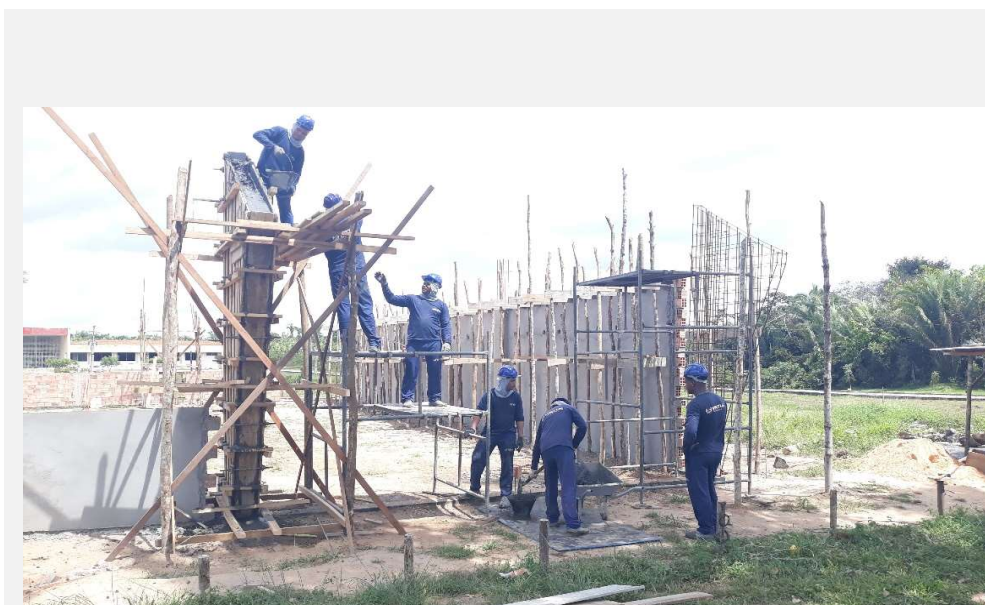
Execução de concretagem de pilares.
