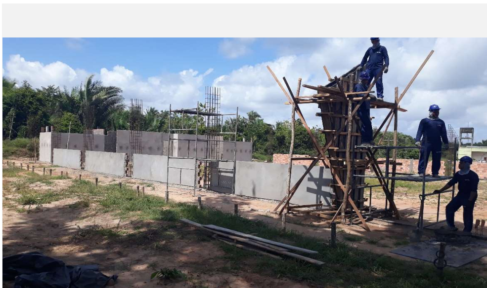
Execução de concretagem de pilares.
