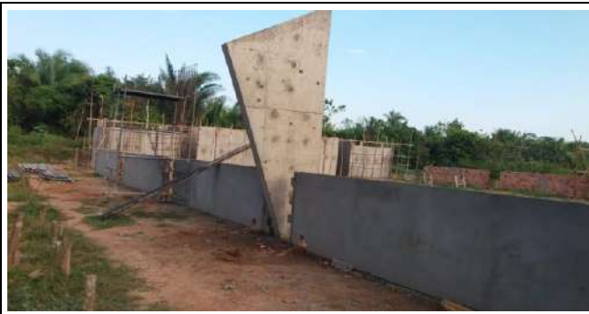
Armação de formas, Ferragens, Concretagem e Desforma dos Pilares de Seção Variável em Concreto Aparente
