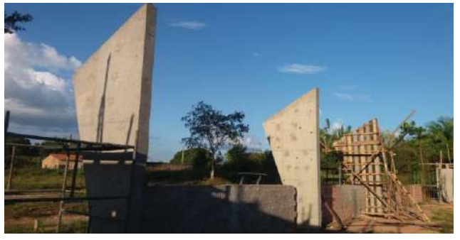
Armação de formas, Ferragens, Concretagem e Desforma dos Pilares de Seção Variável em Concreto Aparente
