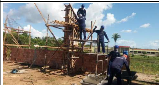
Armação de formas, Ferragens, Concretagem e Desforma dos Pilares de Seção Variável em Concreto Aparente
