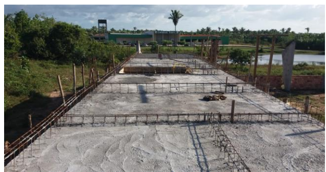
Armação e Montagem da Laje Premoldada
