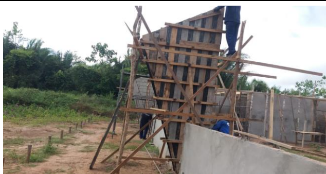
Armação de Formas, Ferragens e Concretagem de Pilares de Seção Variável e Alvenarias da ala das arquibancadas
