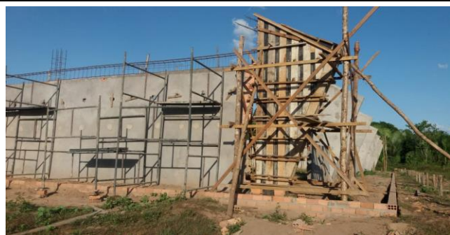
Viga de Superior de Suporte das Paredes em Combogó
