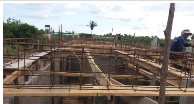
Formas, Ferragens, Concretagem e Desforma dos Pilares de Seção Variável e Armação de Vigas Invertidas de Suporte da Laje Premoldada
