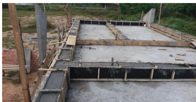
Concretagem do Complemento das Vigas Invertidas e Armação da Laje de Suporte de Reservatório de Água
