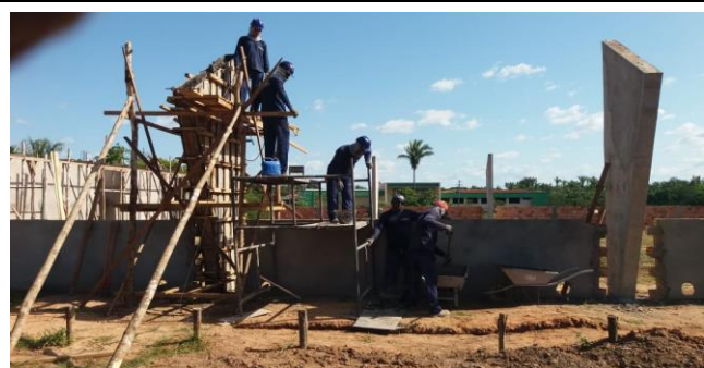
Armação de Formas, Ferragens e Concretagem de Pilares de Seção Variável e Alvenarias da ala das arquibancadas
