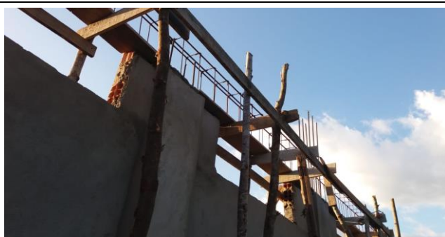
Armação de Formas, Ferragens e Concretagem de Pilares de Seção Variável e Vigas Invertidas de suporte da Laje Premoldada
