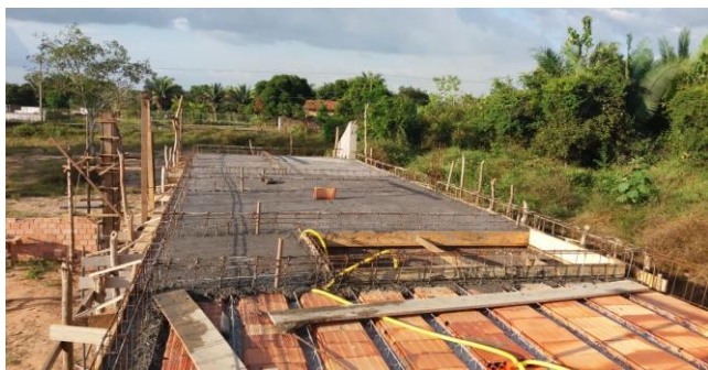
Armação e Montagem da Laje Premoldada
