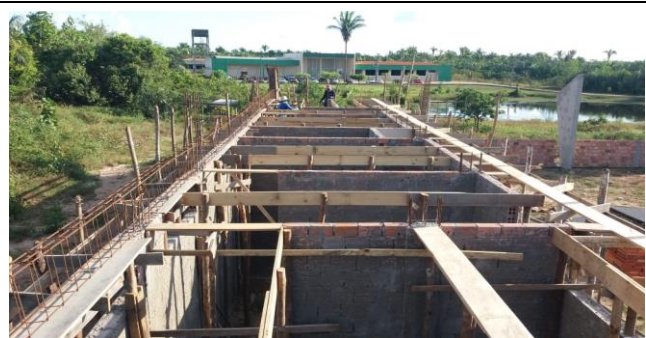
Armação de Vigas Invertidas de Suporte da Laje Premoldada
