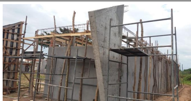
Formas, Ferragens, Concretagem e Desforma dos Pilares de Seção Variável e Armação de Vigas Invertidas de Suporte da Laje Premoldada
