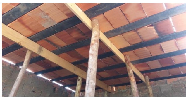
Armação e Montagem e Concretagem da Laje Premoldada
