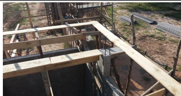
Armação de Vigas Invertidas de Suporte da Laje Premoldada
