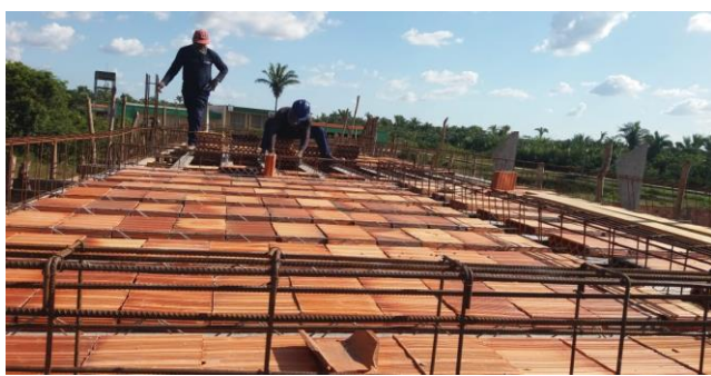
Armação e Montagem e Concretagem da Laje Premoldada
