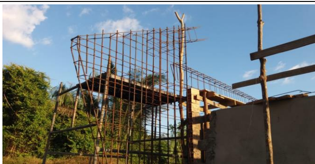
Armação de Formas, Ferragens e Concretagem de Pilares de Seção Variável e Vigas Invertidas de suporte da Laje Premoldada
