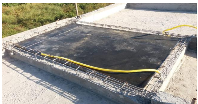
Concretagem do Complemento das Vigas Invertidas e Armação da Laje de Suporte de Reservatório de Água
