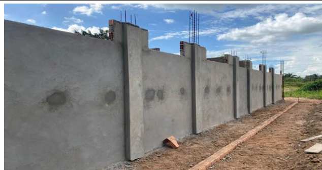
Alicerce e Proteção de Calçadas Externas, Chapisco e Rebouco de Alvenarias e Pilares de Seção Uniforme
