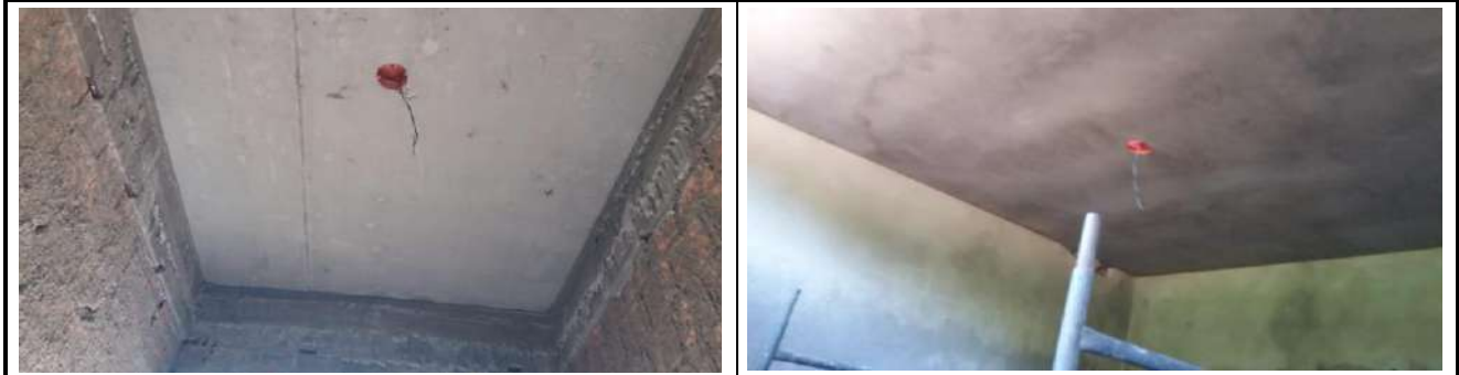
Chapisco, Reboco em Alvenarias e Laje de Cobertura; Fiação Elétrica
