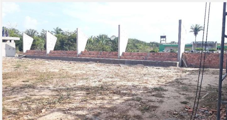
Execução de arquibancada.
