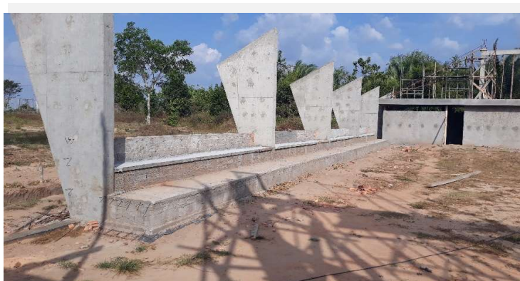
Execução de arquibancada.
