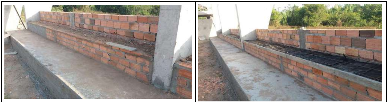
Execução de Degraús de Arquibancada
