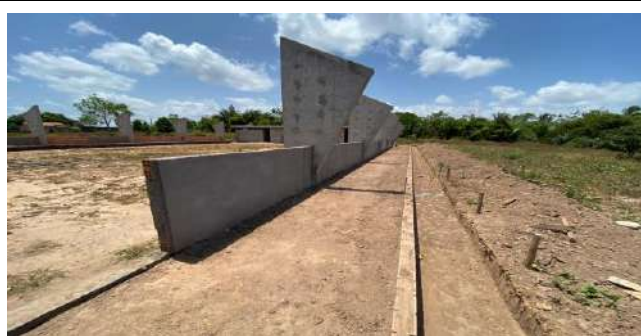
Execução de Calçadas Externas e Canaletas de Drenagem Pluvial
