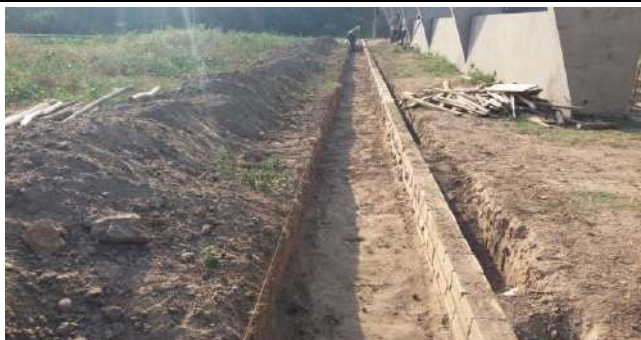
Execução de Calçadas Externas e Canaletas de Drenagem Pluvial
