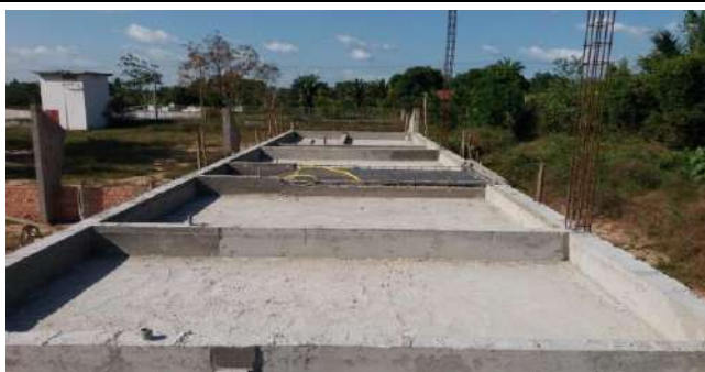
Conclusão da Laje de Cobertura, incluindo as o Complementos das Vigas Invertidas e Laje Suporte do Reservatório
