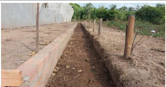
Execução de Calçadas Externas e Canaletas de Drenagem Pluvial
