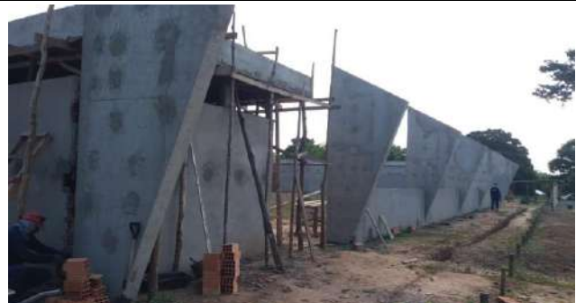
Conclusão dos Pilares de seção Variável
