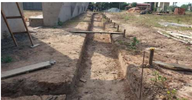
Execução de Calçadas Externas e Canaletas de Drenagem Pluvial
