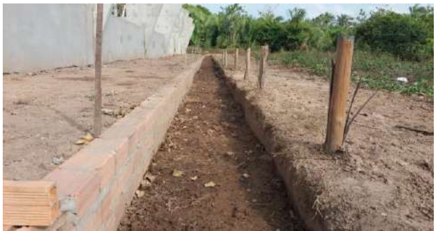
Execução de Calçadas Externas e Canaletas de Drenagem Pluvial
