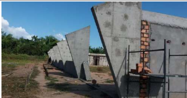
Conclusão dos Pilares de seção Variável
