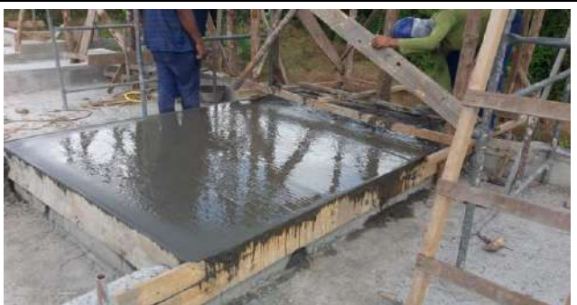
Conclusão da Laje de Cobertura, incluindo as o Complementos das Vigas Invertidas e Laje Suporte do Reservatório
