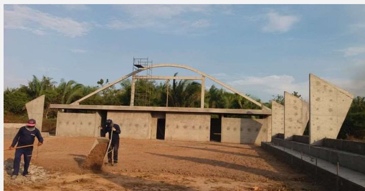
Execução de aterro interno.
