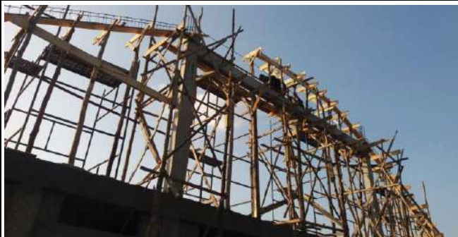
Armação de formas Ferragens, Concretagem e desforma de Pilres e Vigas Superiores
