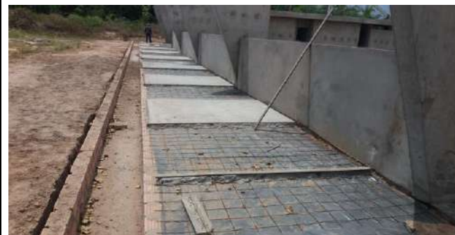
Execução de Calçadas Externas e Canaletas de Drenagem Pluvial e Arquibancadas
