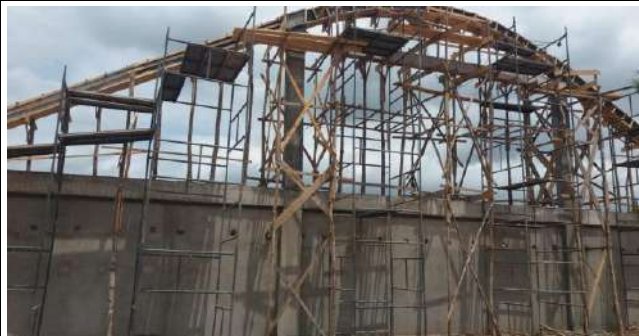
Armação de formas Ferragens, Concretagem e desforma de Pilres e Vigas Superiores
