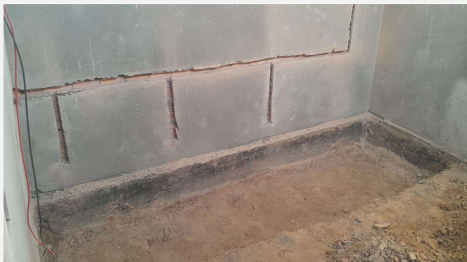
Execução de rasgo em alvenaria e escavação para instalações hidráulicas e sanitárias.
