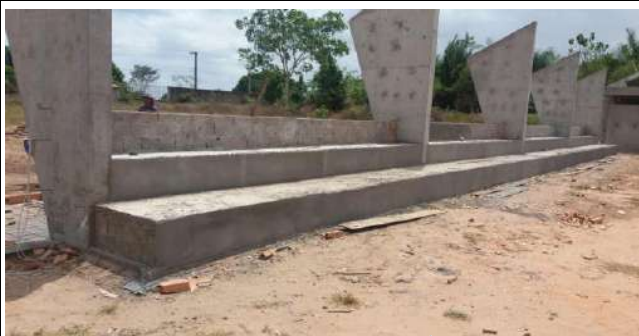
Execução de Degaus de Arquibancada
