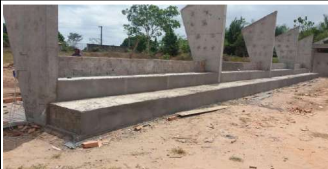
Execução de Degaus de Arquibancada
