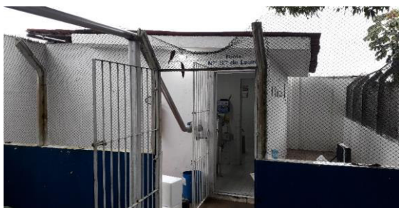
Casa de proteção
