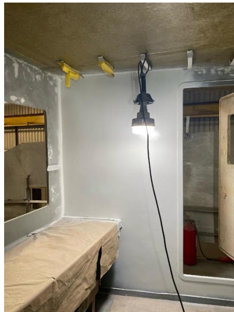
Tratamento e pintura das paredes do laboratório da EapFlu1. Aprovação da cor branco NEPAL
