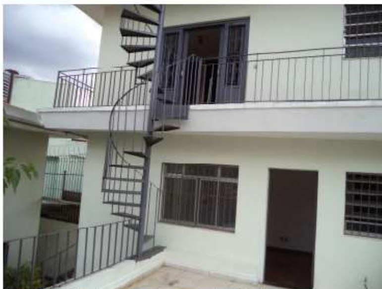
Fotografia 37 — Escada para o segundo andar da segunda edificação.
