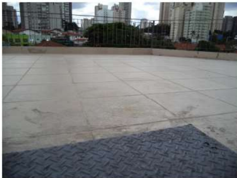
Fotografia 40 – Terraço no terceiro andar da segunda edificação.
