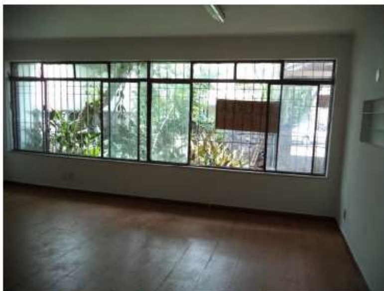
Fotografia 07 – Sala principal do pavimento térreo.
