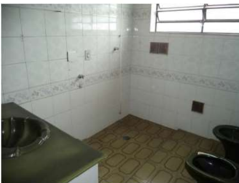
Fotografia 20 – Sanitário do pavimento superior.
