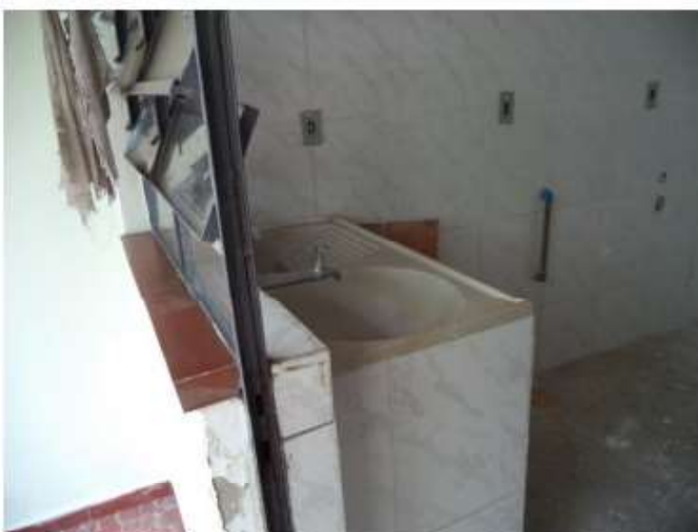
Fotografia 30 – Área de serviço da segunda edificação nos fundos do imóvel.
