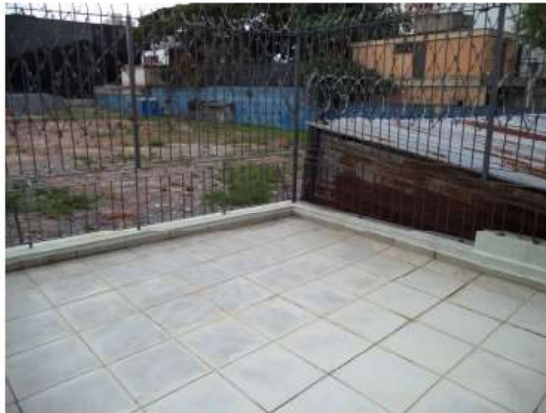
Fotografia 36 – Terraço do pavimento superior da segunda edificação.
