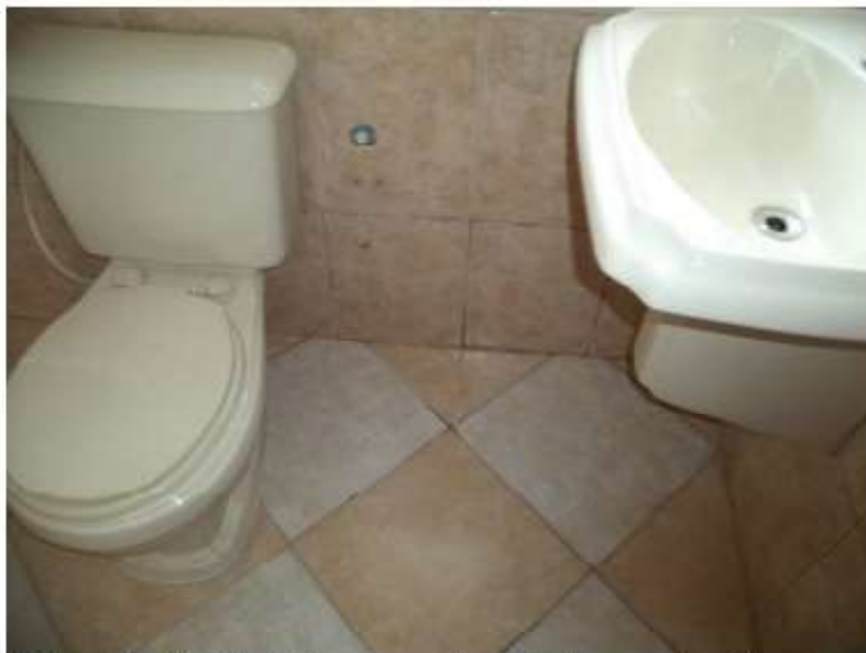
Fotografia 39 – Sanitário no segundo andar da segunda edificação.
