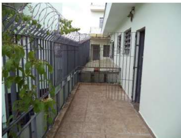
Fotografia 22 – Segunda sacada no pavimento superior.
