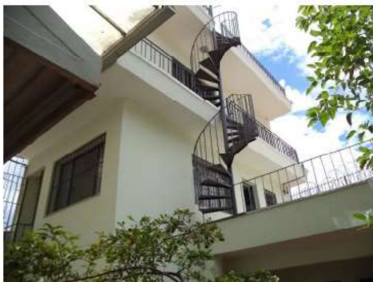
Fotografia 32 – Pavimento superior da segunda edificação nos fundos do imóvel.
