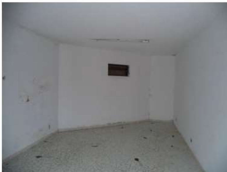
Fotografia 31 – Sala no pavimento térreo da segunda edificação nos fundos do imóvel.
