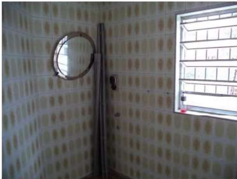
Fotografia 35 – Sanitário da sala no pavimento superior da segunda edificação.
