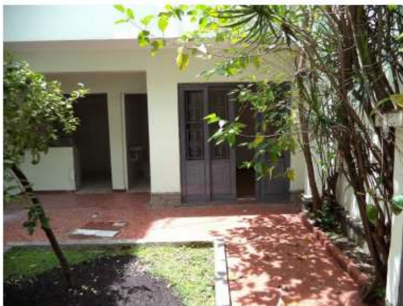
Fotografia 26 – Segunda edificação nos fundos do imóvel.
