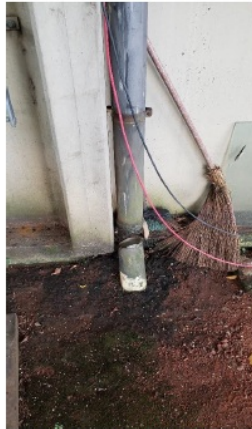
Foto 03 – Ajustes de instalações elétricas
