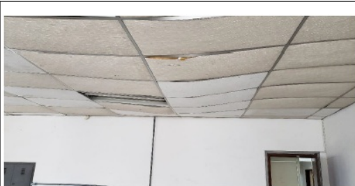
Foto 14 – Reparo de forro
