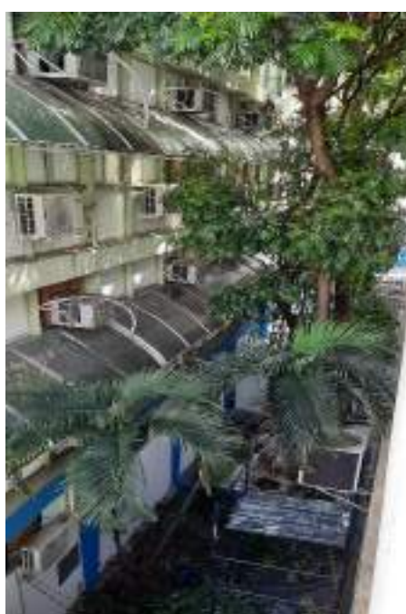
Figura 18 – Vista aérea 2 corredor central
