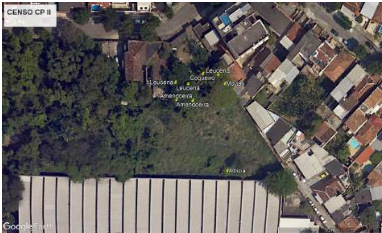
Figura 25- Localização das árvores com risco de queda e que devem ser suprimidas.
