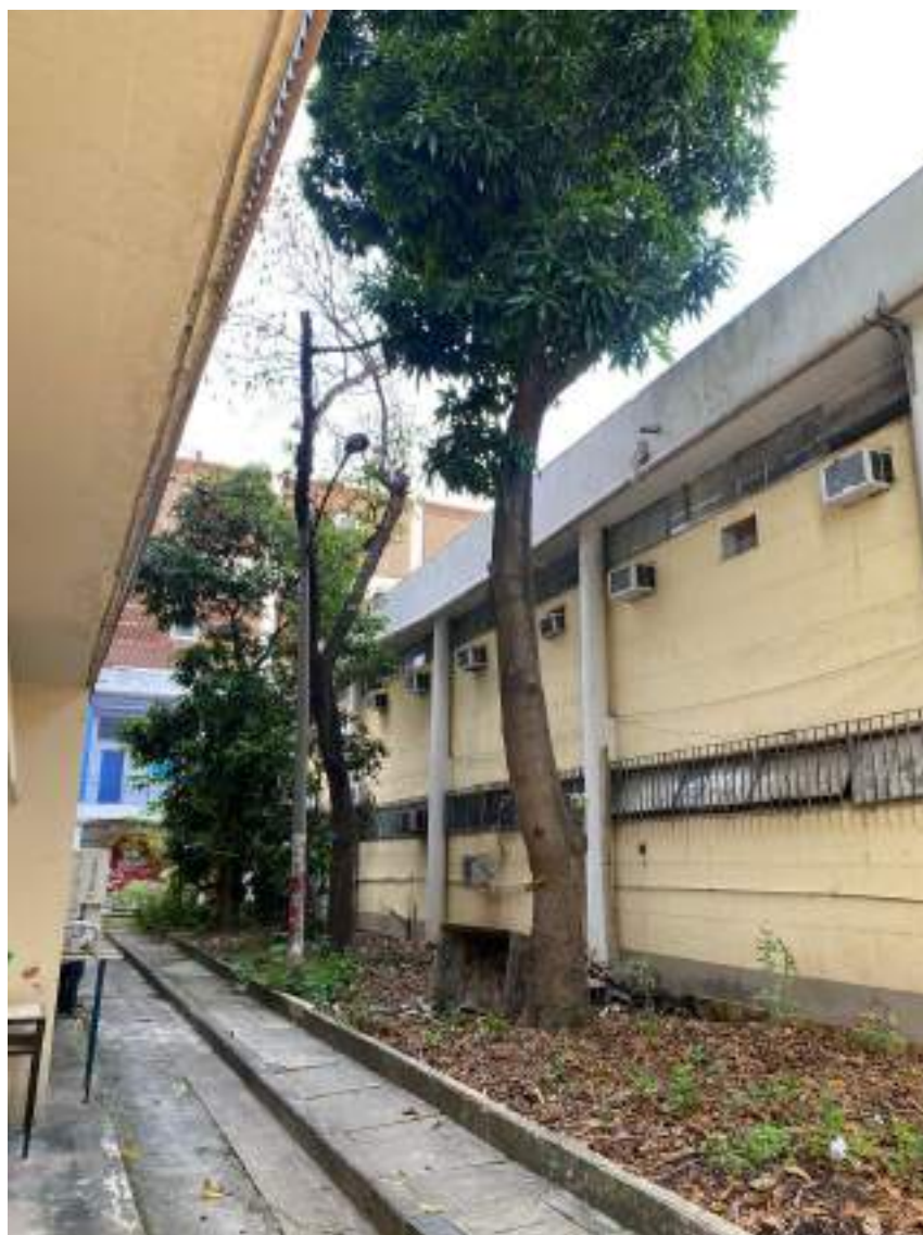
Figura 20- Indivíduos presentes no corredor entre prédios.
