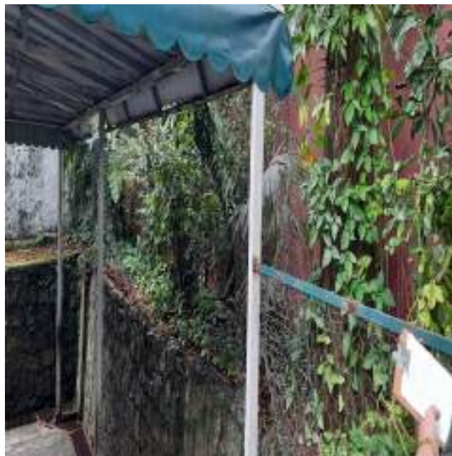
Figura 25 – Vista frontal jardim suspenso
