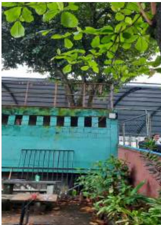
Figura 33 – Árvore sob arquibancada
