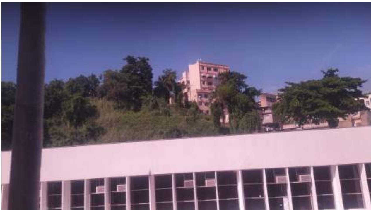
Figura 23- Indivíduos próximos ao muro oferecendo risco de queda.
