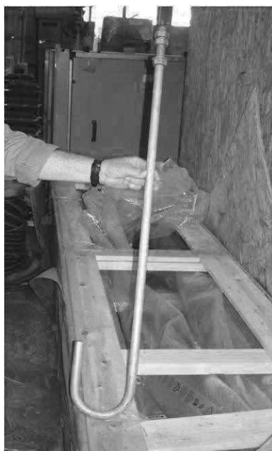
Figura 3 - Chumbadores e gabarito do mastro de medição
