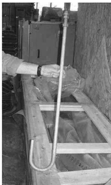
Figura 2 – Chumbadores e gabarito do mastro de medição
