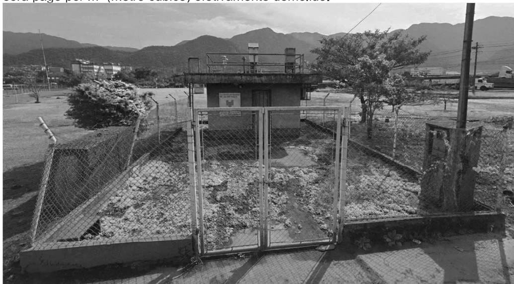
Figura 1 - Antiga Estação Telemétrica
