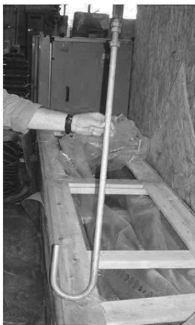
Figura 4 – Chumbadores e gabarito do mastro de medição
