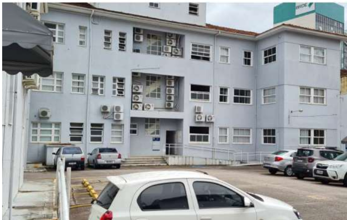
Figura 2: SRA/SC – Bloco A – fachada interna
