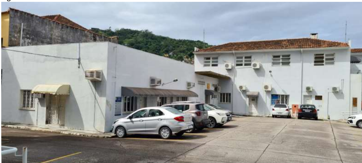
Figura 5: Bloco C – fachadas internas
