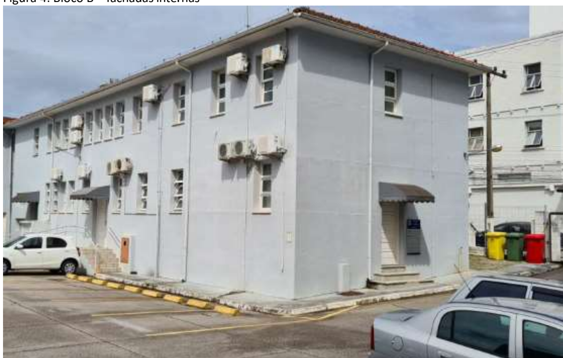
Figura 4: Bloco B – fachadas internas
