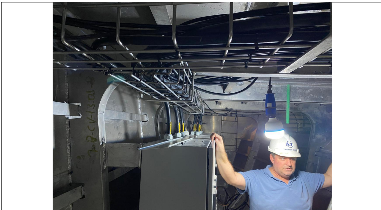
Conclusão da rota e passagem de cabos elétricos
