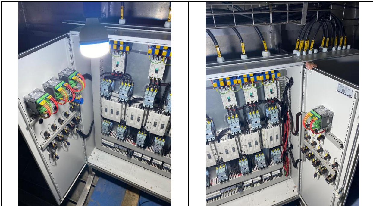
Instalação dos quadros elétricos
