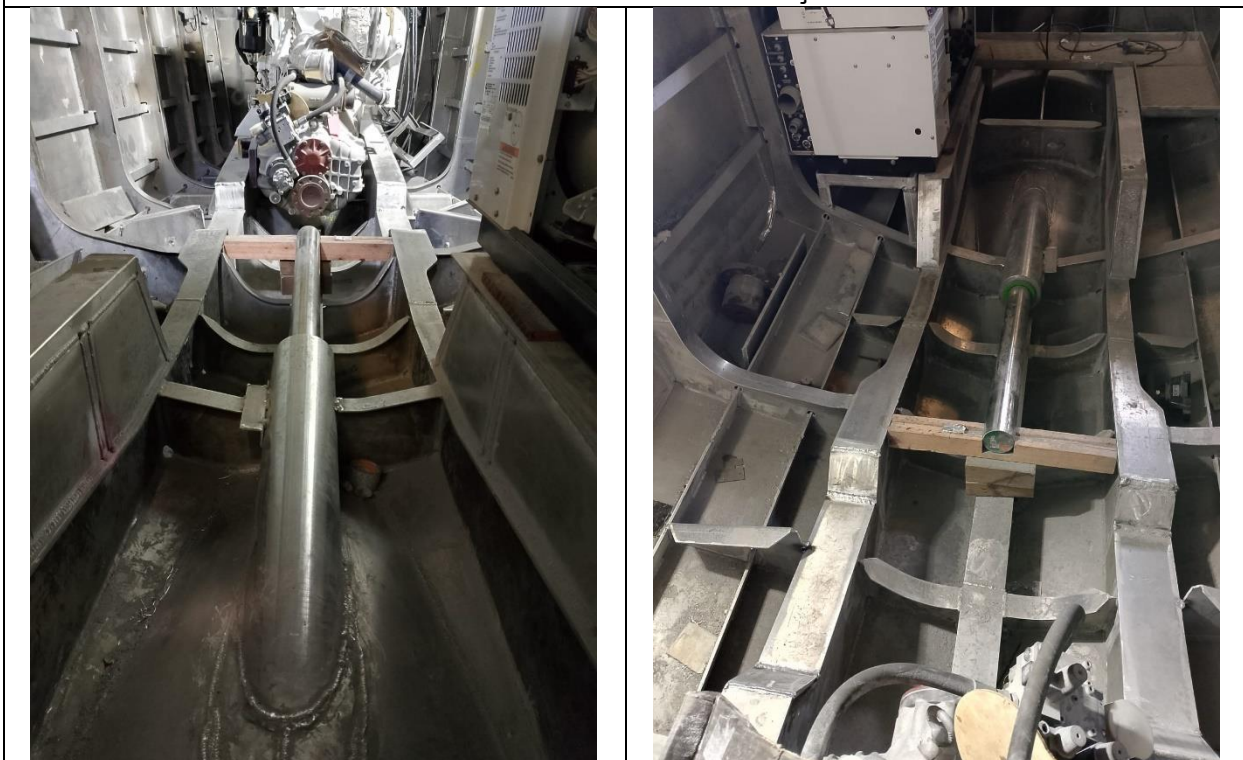
Alinhamentos dos motores e reversoras
