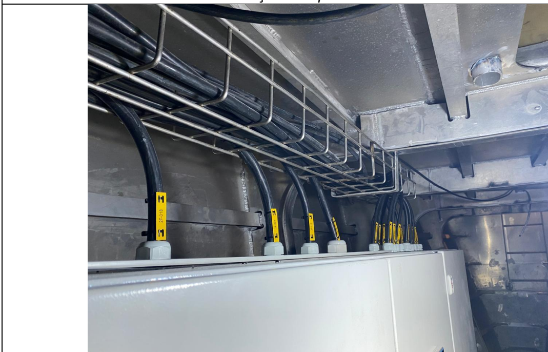
Conclusão da rota e passagem de cabos elétricos
