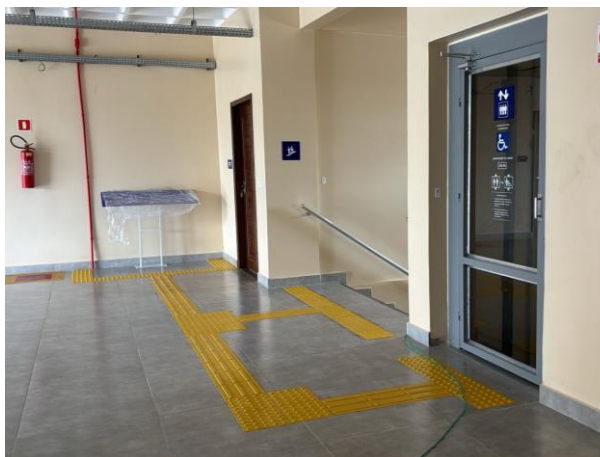
Figura 9– Sinalização acessível vertical e horizontal instalada no Campus Monte Alegre - UFOPA
