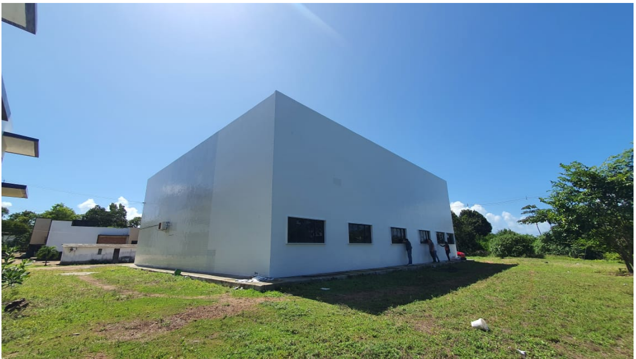
Foto 03: Vista externa da obra e seu entorno.
