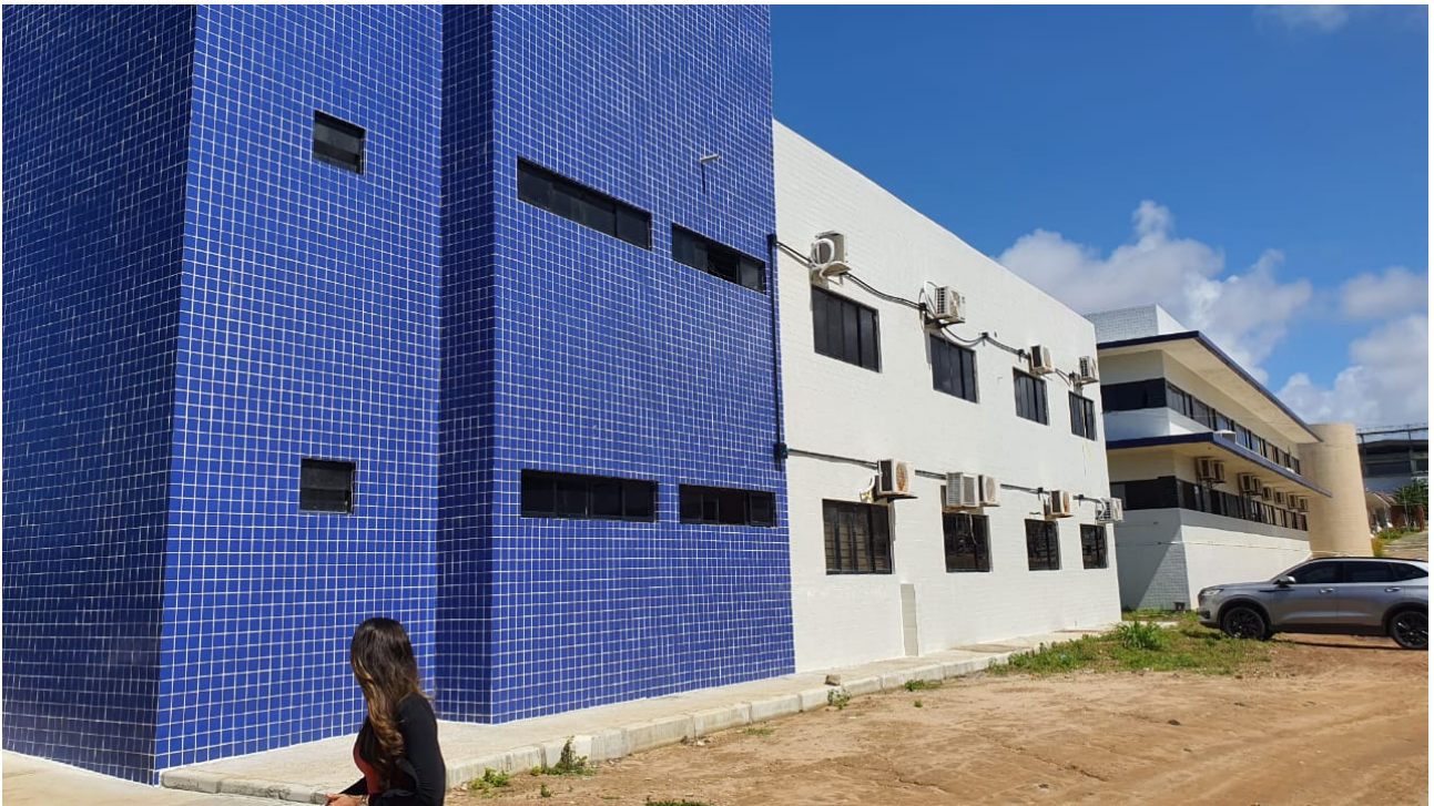
Foto 04: Vista externa da obra e seu entorno.
