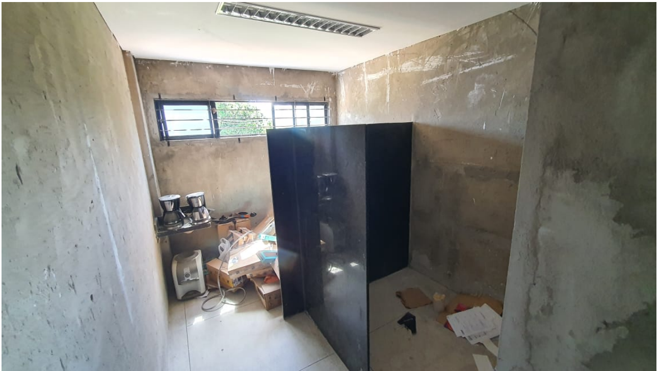
Foto 07: Banheiro a ser finalizado.
