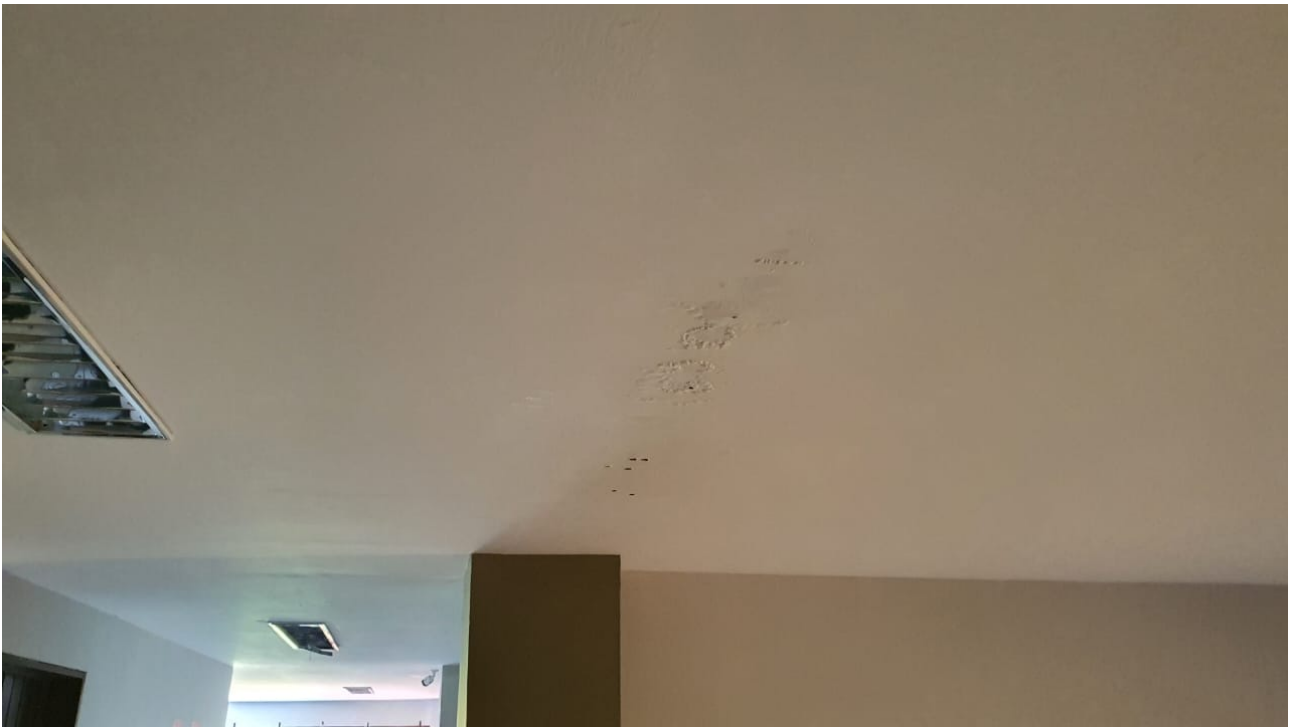
Foto 11: Infiltrações internas.
