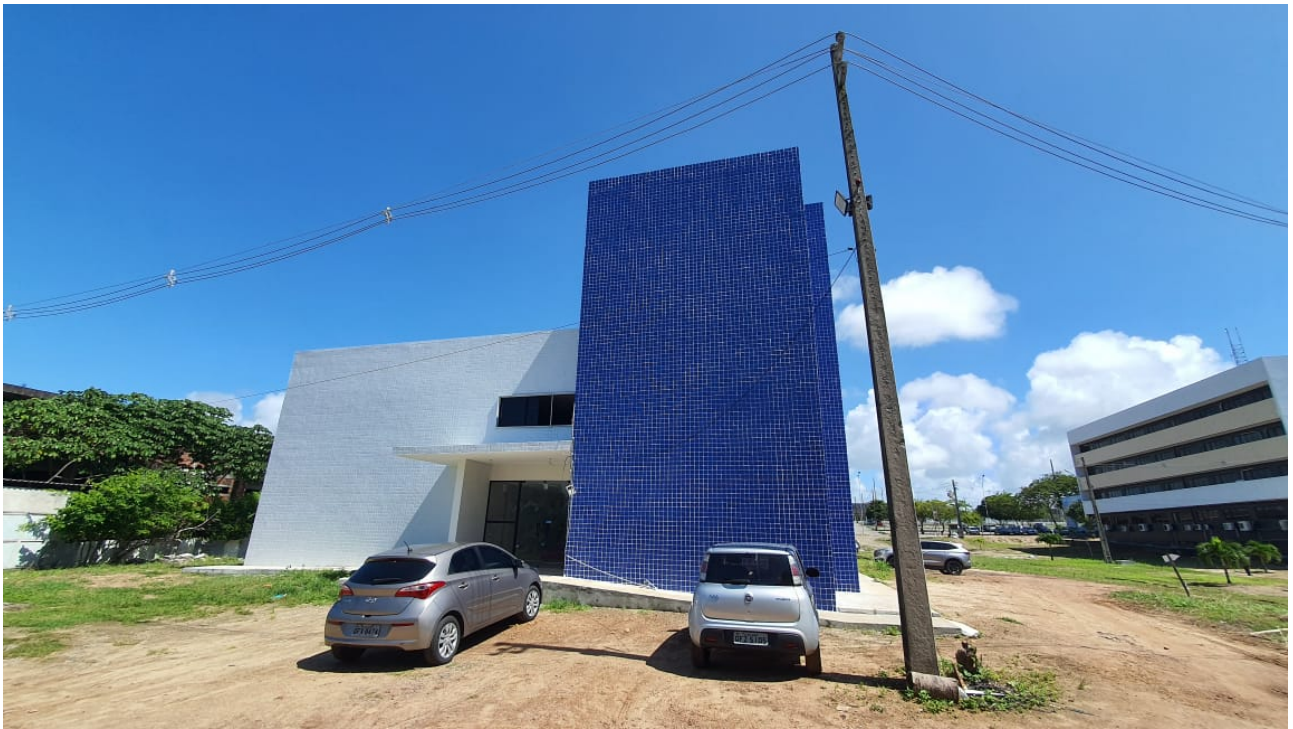
Foto 02: Vista externa da obra e seu entorno.
