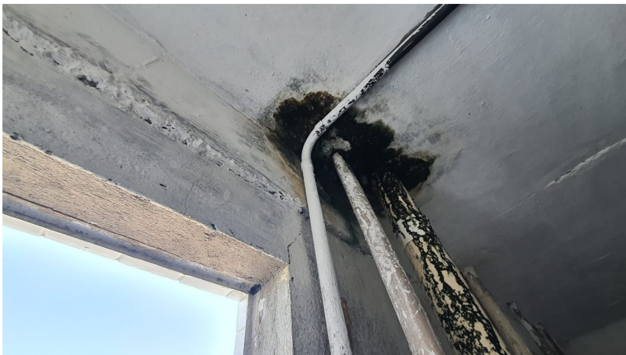
Foto 10: Infiltrações internas.
