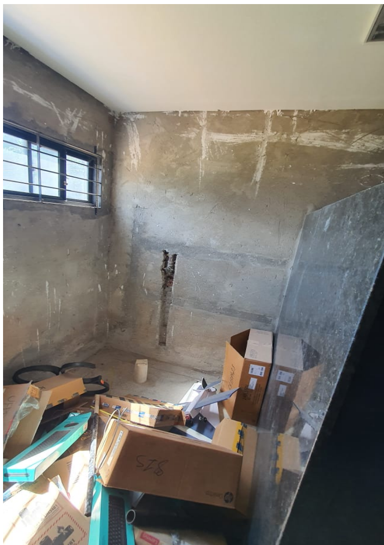
Foto 06: Banheiro a ser finalizado.
