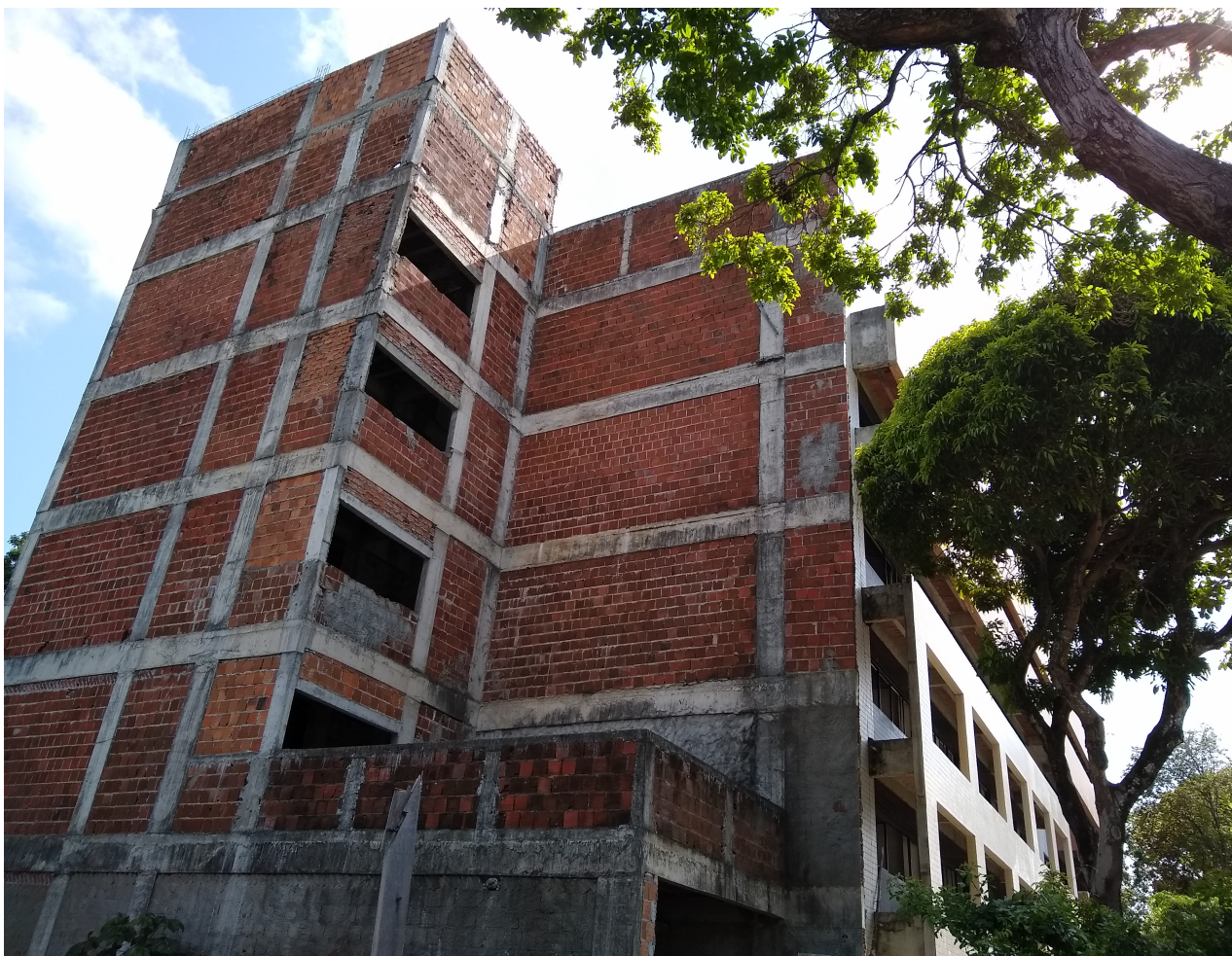
Foto 01: Fachada lateral do CBIOTEC
