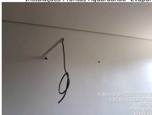
Instalações Aguardando os Equipamentos Hi-Wall
