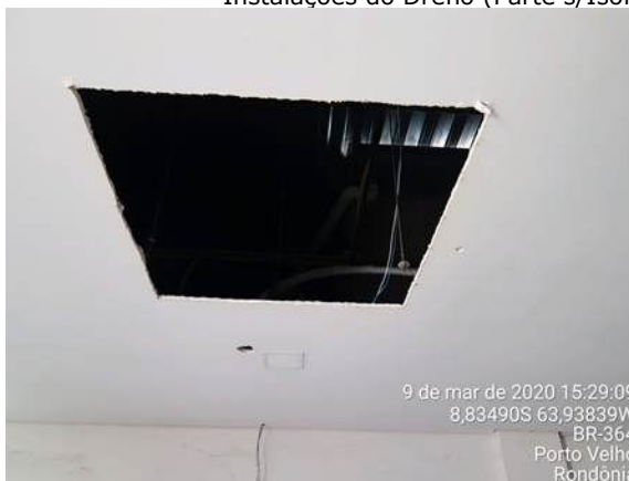
Instalações Prontas Aguardando Evaporadora Cassete de 4 Vias (SALA MULTIUSO)
