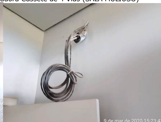
Instalações Aguardando os Equipamentos Hi-Wall
