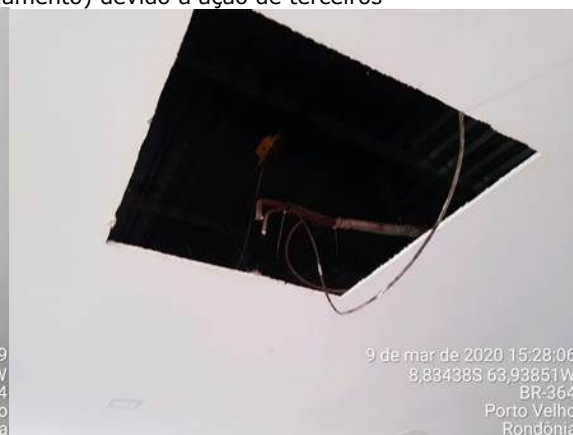
Instalações Prontas Aguardando Evaporadora Cassete de 4 Vias (SALA MULTIUSO)
