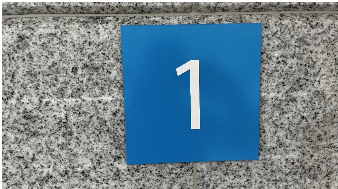
Figura 14: Exemplo de placa de numeração de pavimento
