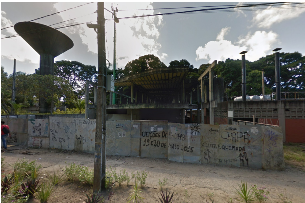
Foto 01: Fachada atual da Unidade de Hospitalidade
