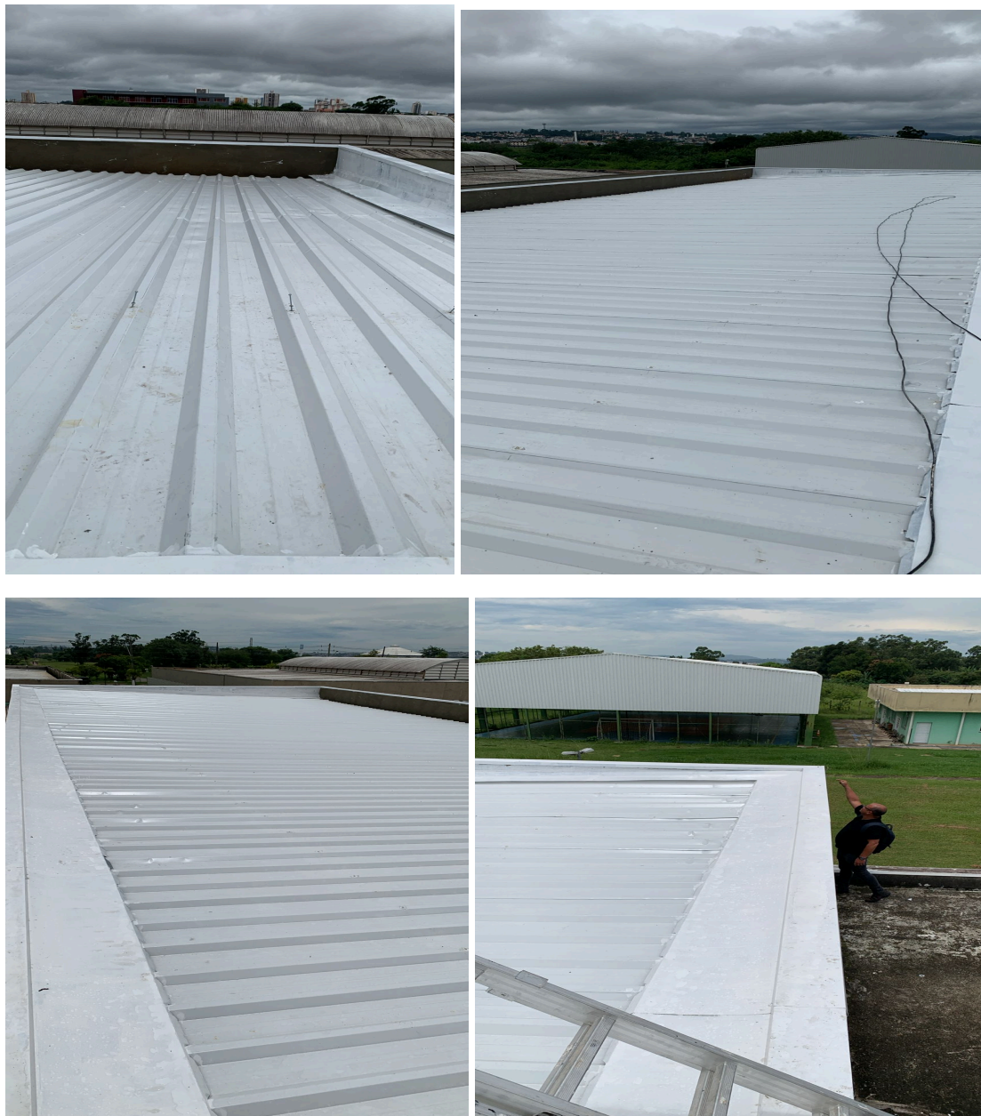
Foto 01 – Substituição das telhas amassadas e instalação da fita do SPDA .
