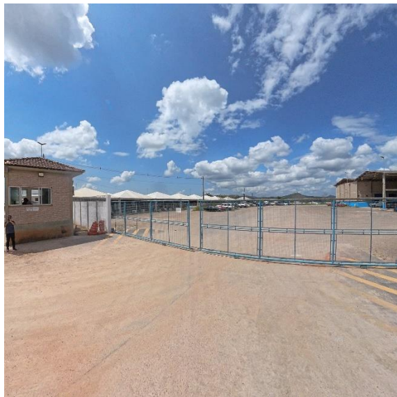
Imagem 4 - Entrada da IRF com pavimento recuperado
