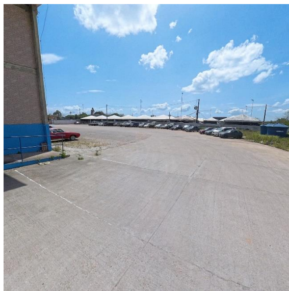
Imagem 8 - Detalhe do trecho recuperado em pavimento rígido - acabamento do concreto e juntas de dilatação
