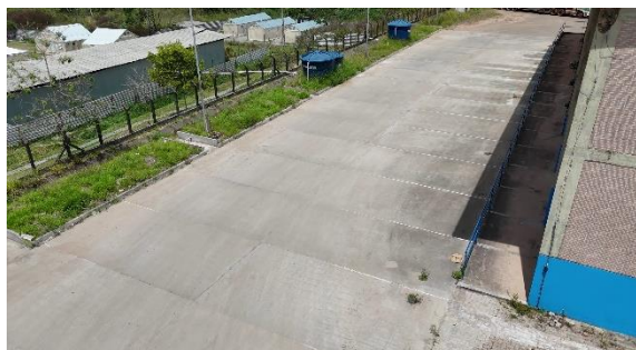
Imagem 6 - Trecho recuperado em pavimento rígido
