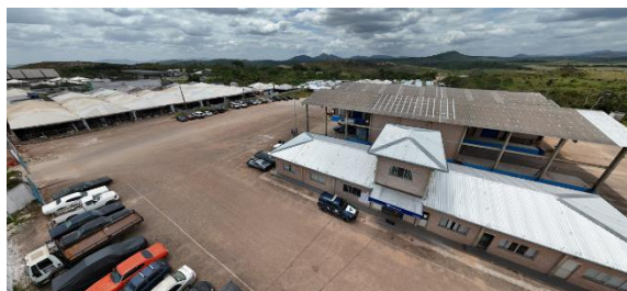
Imagem 15 - Vista panorâmica do pátio pavimentado, com área livre de entulhos e equipamentos após intervenções da obra
