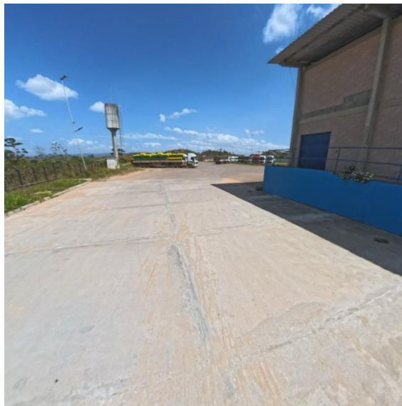
Imagem 7 - Detalhe do trecho recuperado em pavimento rígido - acabamento do concreto e juntas de dilatação
