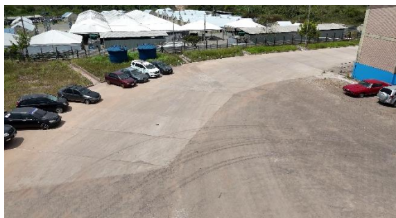
Imagem 5 - Trecho recuperado em pavimento rígido
