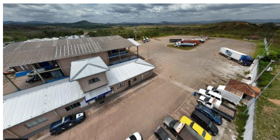
Imagem 16 - Vista panorâmica do pátio pavimentado, com área livre de entulhos e equipamentos após intervenções da obra
