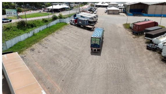
Imagem 11 - Visão aérea pátio recuperado
