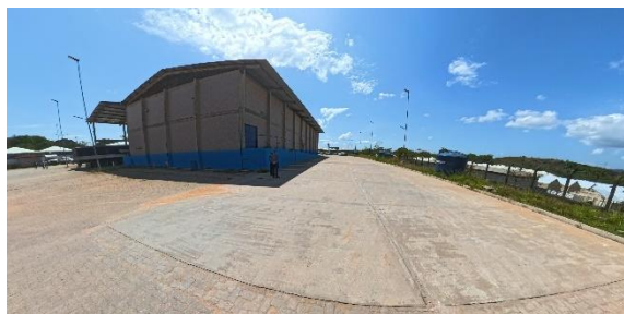
Imagem 9 - Detalhe do trecho recuperado em pavimento rígido com pavimento intertravado recuperado
