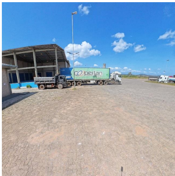
Imagem 12 - Área do pátio recuperada próximo ao prédio administração
