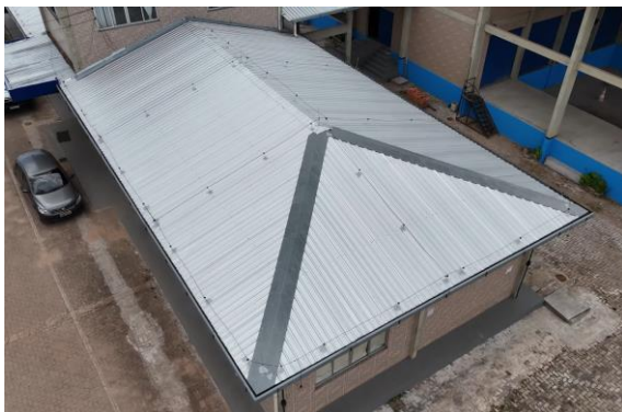
Imagem 2 - Vista da cobertura substituída do Bloco Administrativo e SPDA instalado
