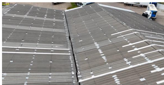
Imagem 16 - SPDA instalado no DMA
