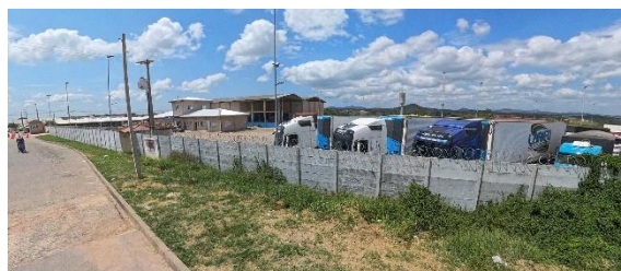
Imagem 10 - Vista do Muro de Contorno
