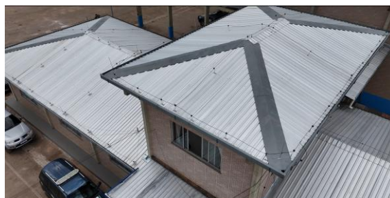
Imagem 3 - Vista da cobertura substituída do Bloco Administrativo e SPDA instalado
