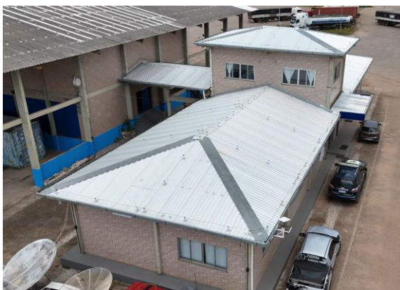
Imagem 1 - Vista da cobertura substituída do Bloco Administrativo e SPDA instalado
