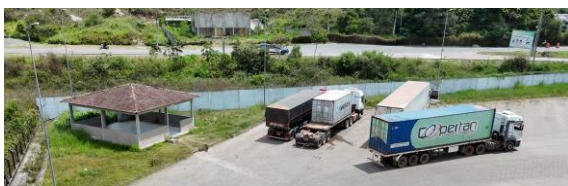
Imagem 7 - Vista do Muro de Contorno
