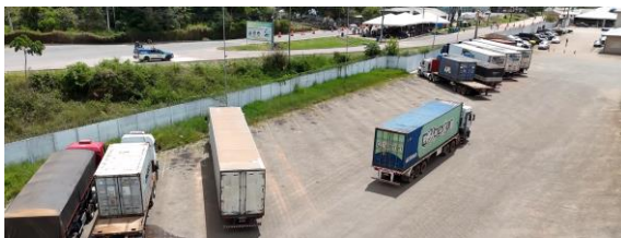
Imagem 8 - Vista do Muro de Contorno
